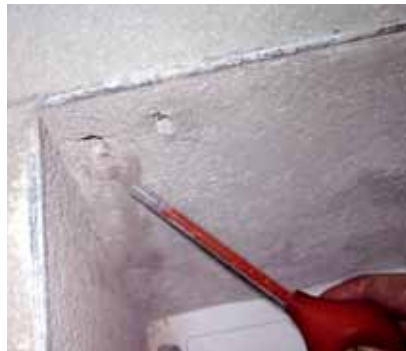
Innenputz als luftdichtende Schicht: besonders anfällig bei porosiertem und gelochtem Mauerwerk
