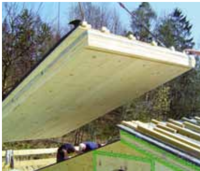
Einsatz von vorgefertigten Vakuumdämmelementen (Quelle: Variotec)
