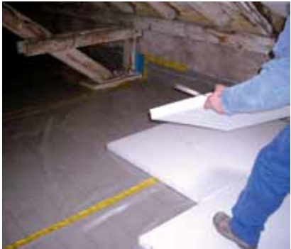
Luftdichtung, 25 cm Dämmung und Estrich auf der obersten Geschossdecke
