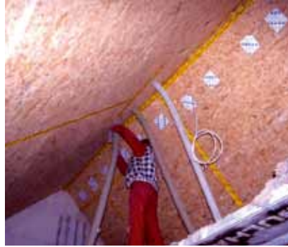
Schrägdach-Dämmung mit Zellulose-Einblasdämmung
