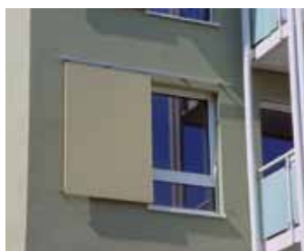
Fenster mit Schiebeladen
