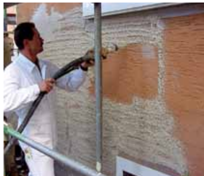
Luftdichtung in der Kleber-Ebene des WDVS bei Sanierung im bewohnten Zustand
