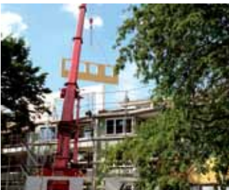
Montage der Passivhauswohnungen im Dach
