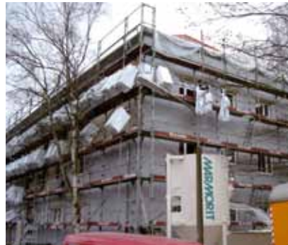
Wärmedämmverbundsystem (WDVS) am Jean-Paul-Platz 4, Nürnberg
