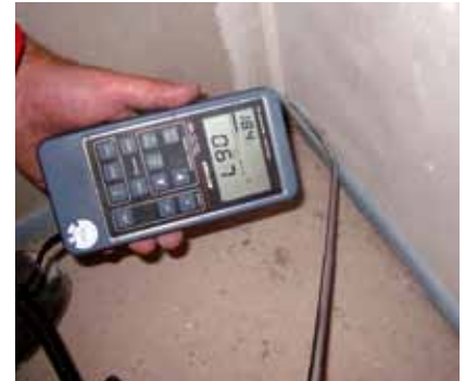
Fehlerquellen beim Estrich: Lecks in Decke, Innenputz, Fenster-Verklebungen und Durchbrüchen
