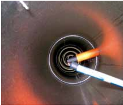
Vorheizregister zum Frostschutz mit Temperatursensoren und Heizspindel
