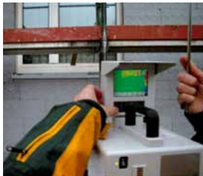
Baubegleitende Qualitätssicherung mittels Infrarot-Thermografie
