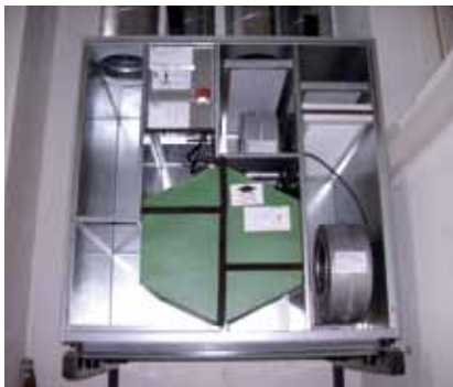
Lüftungsgerät für eine Wohneinheit
