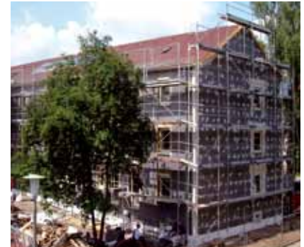
Dämmung 20 cm WLG 035 gedübelt und z. T. verspachtelt (Ingolstädter Straße, Nürnberg)
