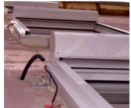
Hochwertige Fenster mit gedämmtem Rahmen und 3-fach-Wärmeschutzverglasung
