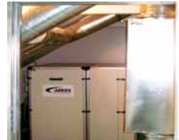
Lüftungszentrale im Bauzustand
