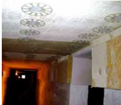
Dämmung der KG-Decke mit Mineralfaserdämmung 20 cm dick
