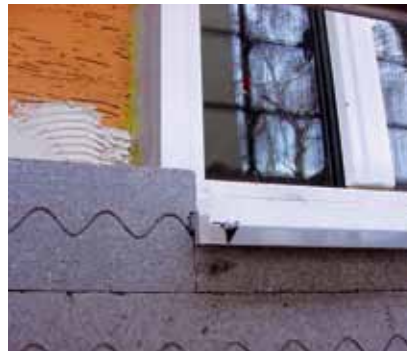
Sorgfältige Detaillösung, z. B. im Bereich des Fensterblechs (Quelle Marmorit)
