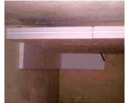
Kellerdeckendämmung mit 14 cm Polystyrol
