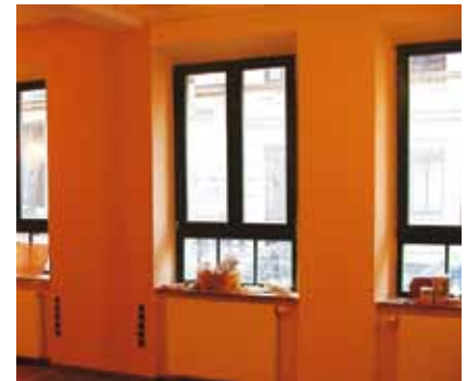
Innendämmung bei einem Gründerzeitgebäude 6–12 cm dick
