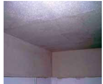
Fertige Spachtelung der Konstruktion oben
