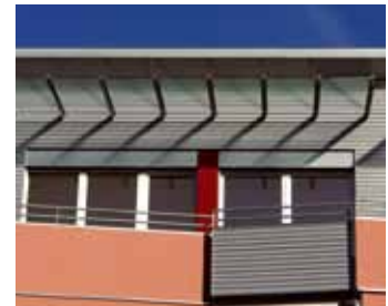
Detailansicht im Dachbereich
