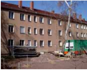
Ingolstädter Straße vor Sanierung
