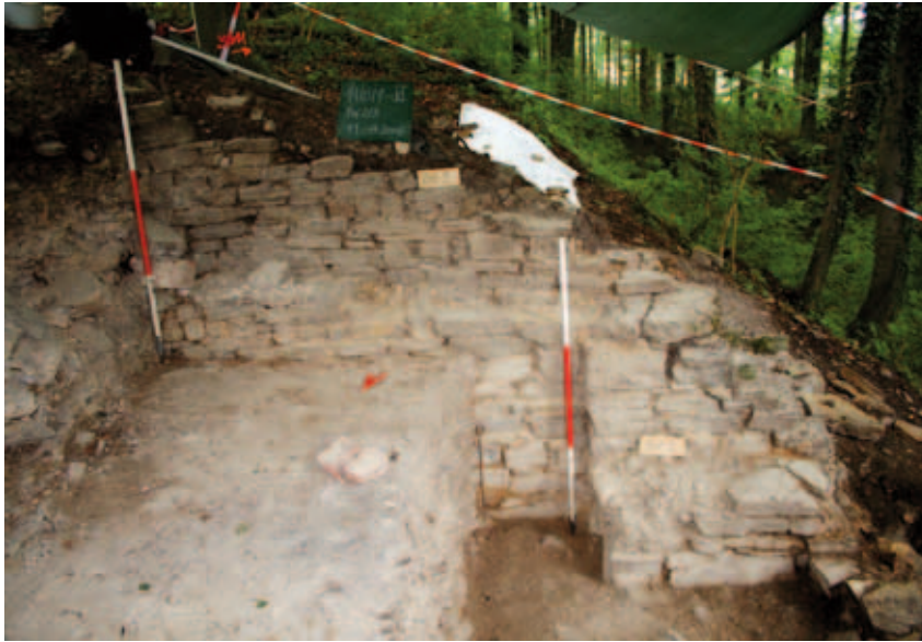
Abb. 1: Erodierendes Mauerwerk des Kammertores an der Grabenkante
