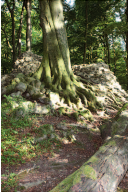
Abb. 4: Von Wurzeln umschlossenes Mauerwerk
