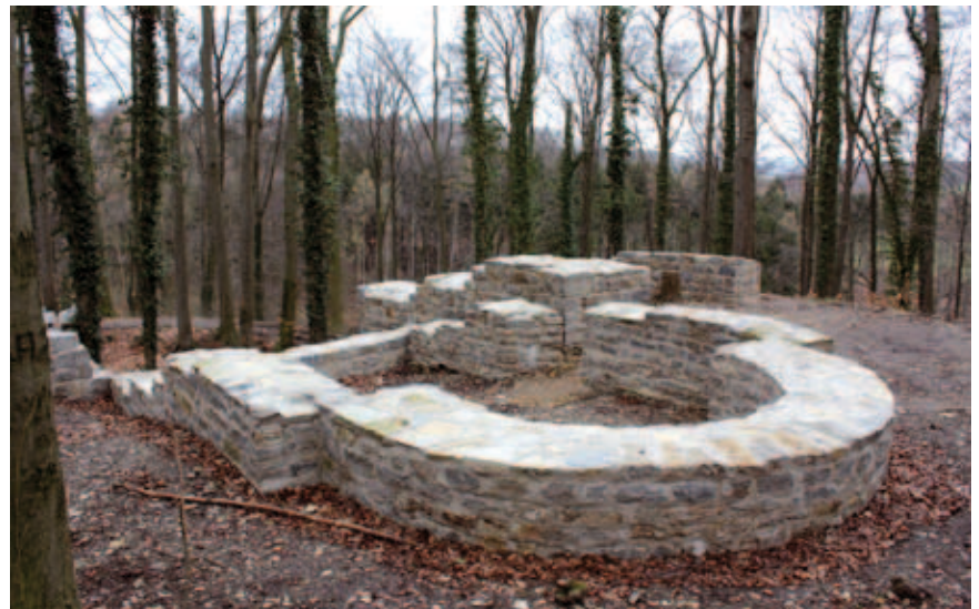
Abb. 9: Tor und Kapelle nach Abschluss der Konservierungsmaßnahmen
