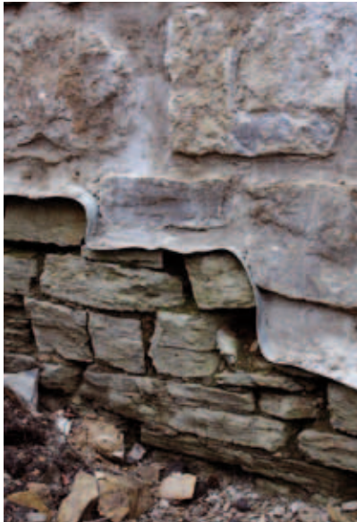
Abb. 8: Trennung des historischen Mauerwerkes von der aufgemauerten Verschleißschicht durch eingelegtes Bleiband
