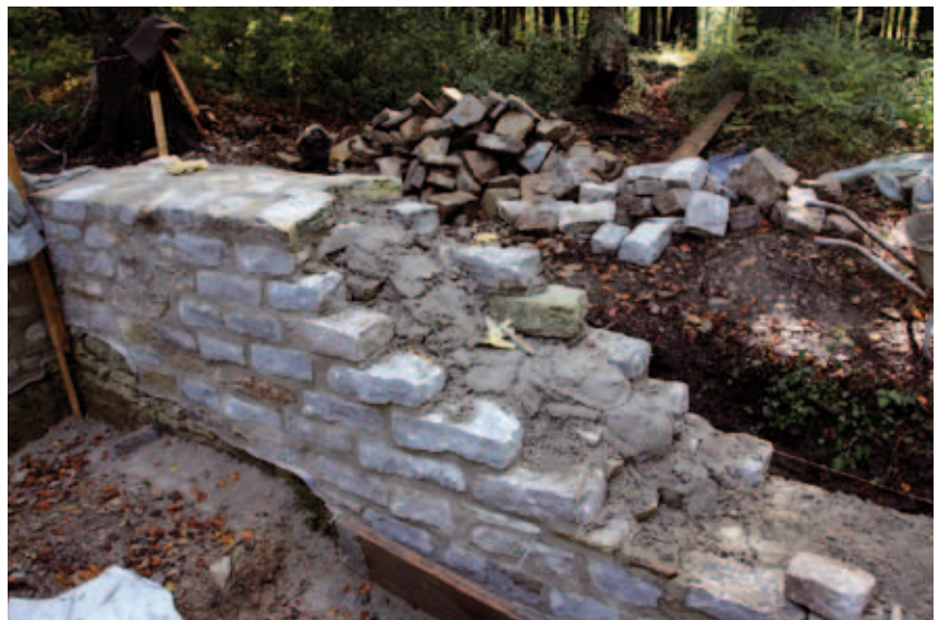
Abb. 7: Aufmauerung der Verschleißschicht
