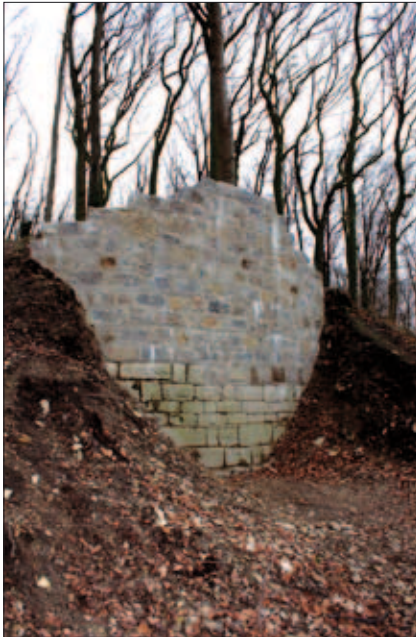
Abb. 6: Bergfriedabschnitt nach der Konservierung
