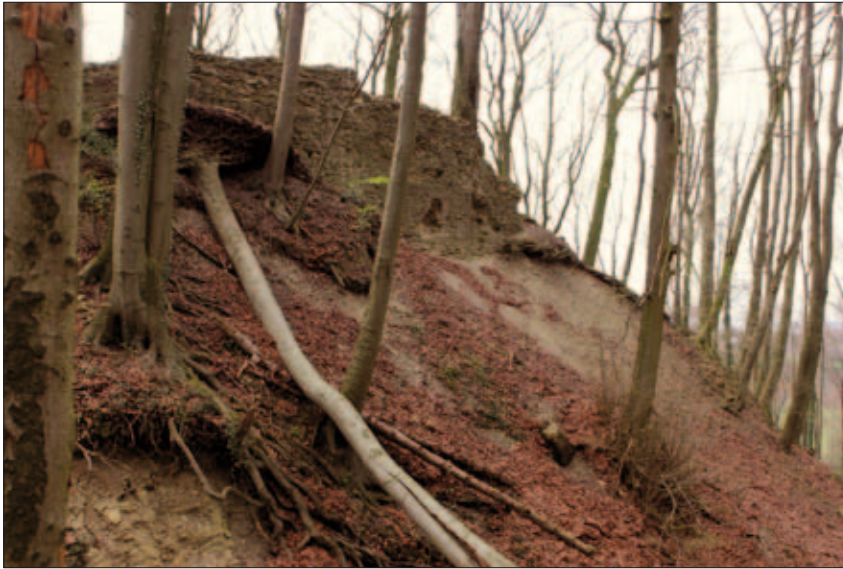
Abb. 3: Gefährdung des Mauerwerks durch Windwurf
