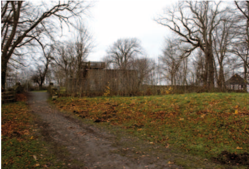
Abb. 4: Harzburg: Blick nach Westen auf den aufgemauerten quadratischen Turm mit Aussichtsplattform
