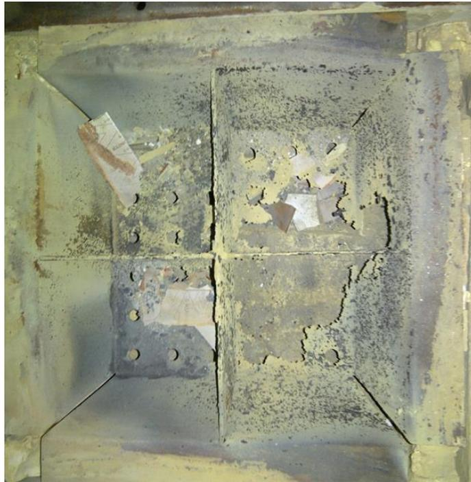
**Bild 1:** Aufgelöste Metallteile im Regeneratorfuß
