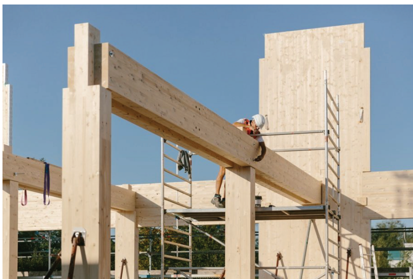
Abb. 8: (links) Baustelle, Fotograf Bengt Stiller http://bengtstiller.de/
