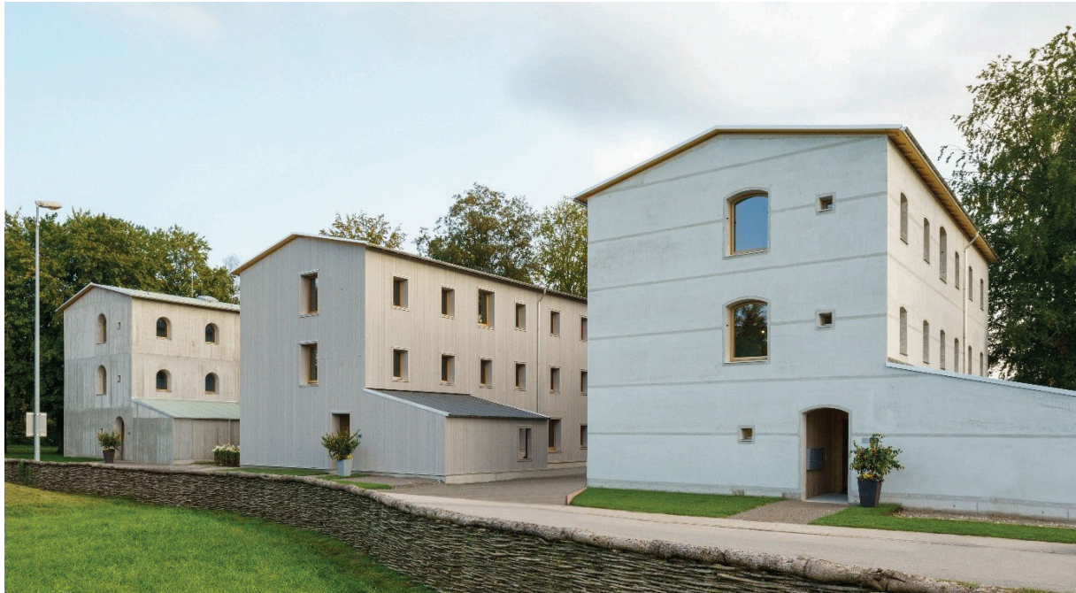
Abb. 21: Die drei Forschungshäuser nach Fertigstellung, Foto: B&O Gruppe
