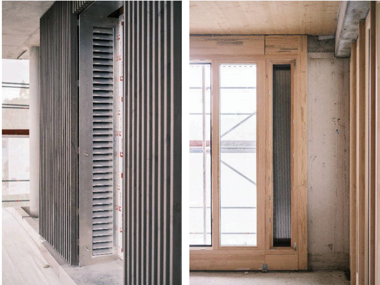
Abb. 13: Außen- und Innenansicht der fensterhohen Lüftungskammern, welche die Wohnungen auf natürliche Art und Weise mit Frischluft versorgen © P.W.S.
