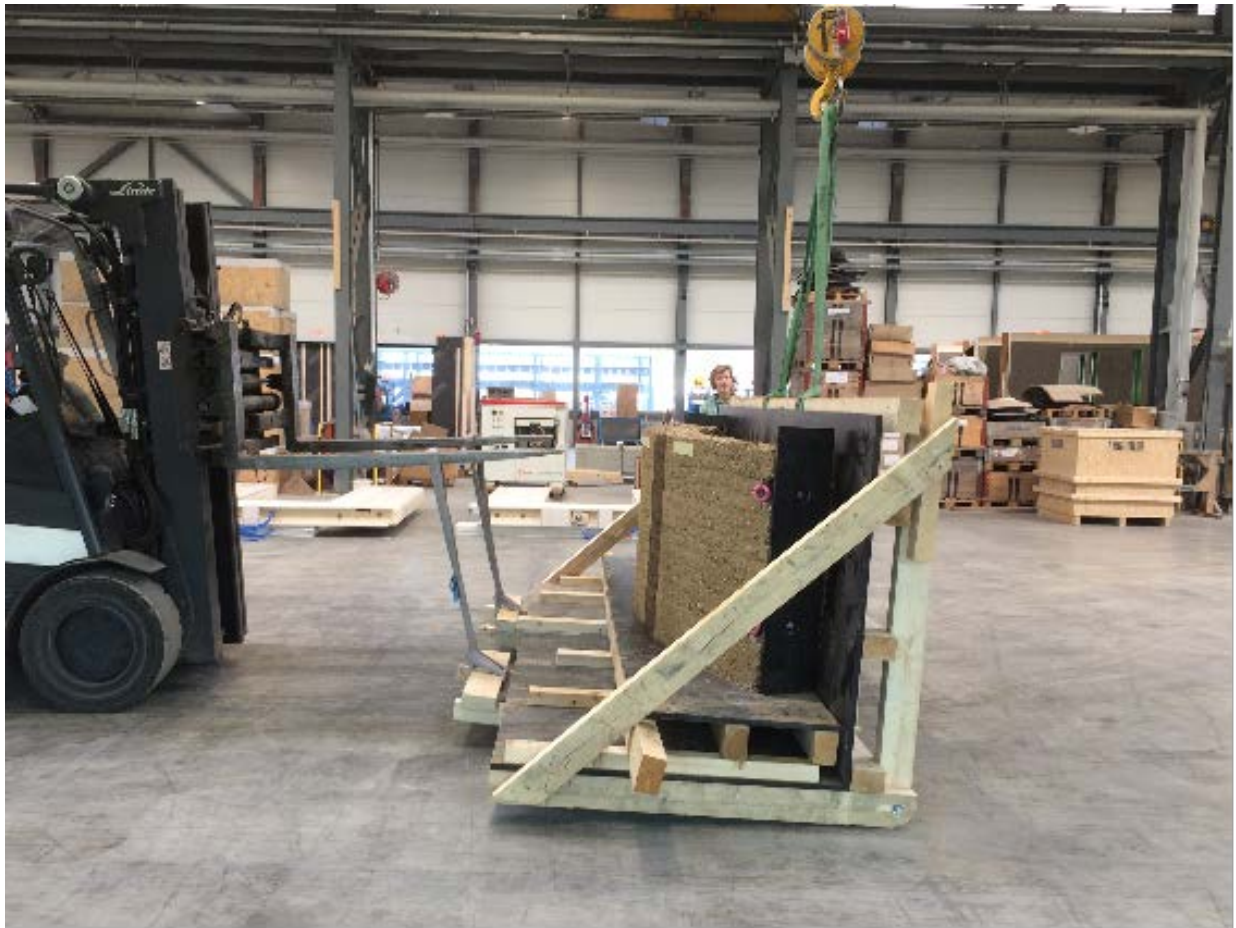
1 Drehen eines Bogenelements mit dem Kipptisch im Projekt KalZ © wh-p Ingenieure
