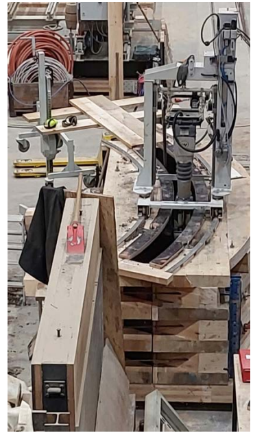
5 Verdichtung mit schienengeführtem Vibrations-Stampfer © LehmTonErde
