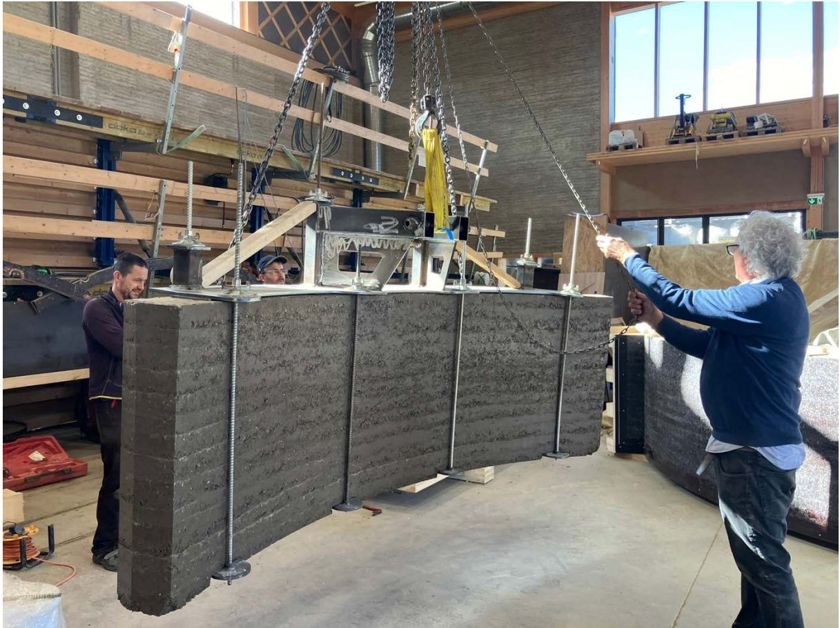
Abbildung 7 Drehvorgang des feuchten Bogens (ohne Zugstangen)
