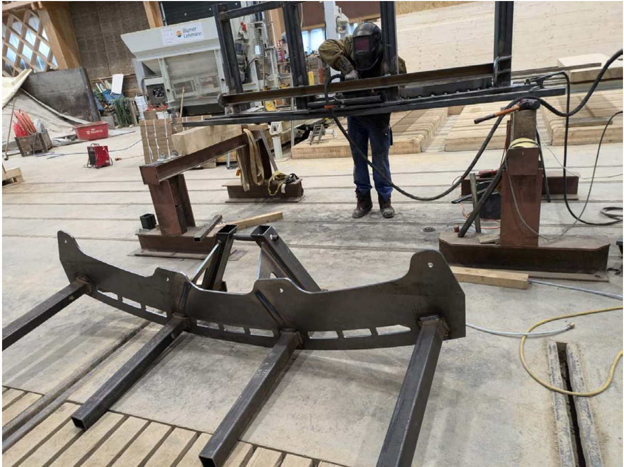
6 Greifarm für den Drehvorgang © LehmTonErde
