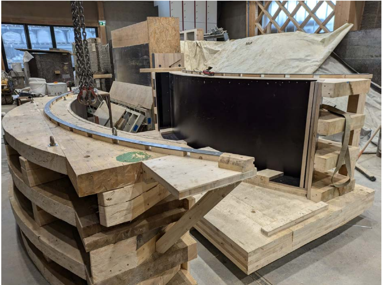
Abbildung 4 weiter entwickelte Schalung © LehmTonErde
