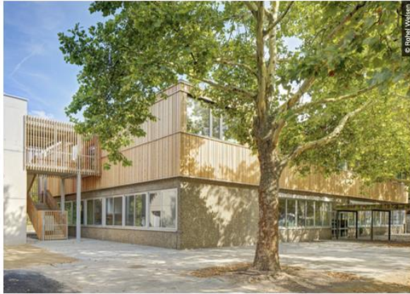
Die Aufstockung der Erich-Kästner-Schule in Darmstadt-Kranichstein bietet eine durchdachte Lösung zur Schaffung von acht zusätzlichen Klassenräumen. Anstatt das Gelände weiter zu versiegeln, wurde der eingeschossige Gebäudeteil vertikal erweitert.
