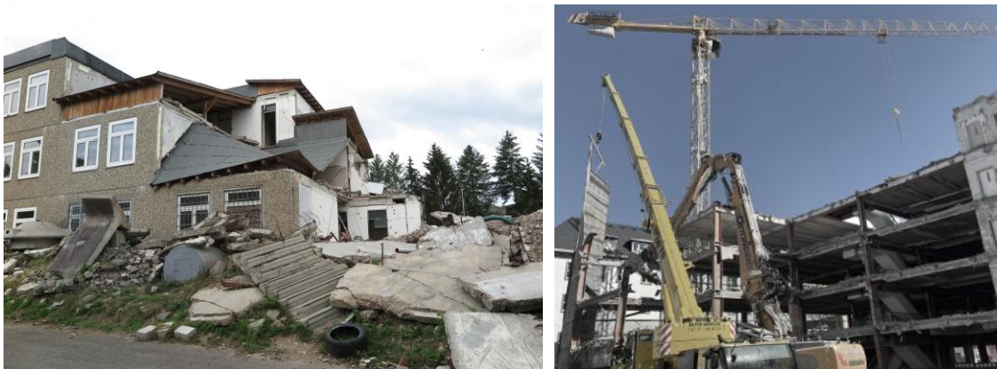
Anhang A1 1-1: Konventioneller Rückbau von Gebäuden aus Stahlbeton [Fotos IMB-MB]
