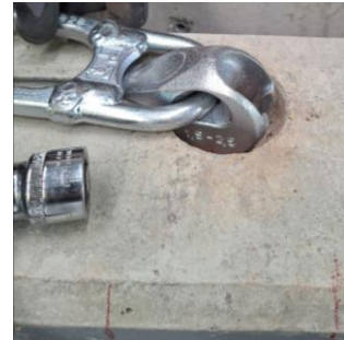
c) Nachträgliche Anbringung von Transportankern
