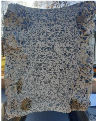
a) Schnittstelle durch Kernbohren
