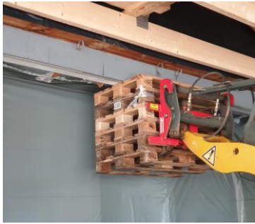
a) Temporäre Stützkonstruktion
