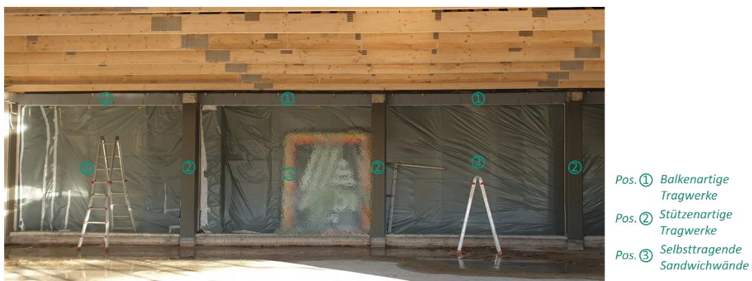
Abbildung 6-1: Übersicht zum Rückbauvorhaben während der Bauwerksbegehung
