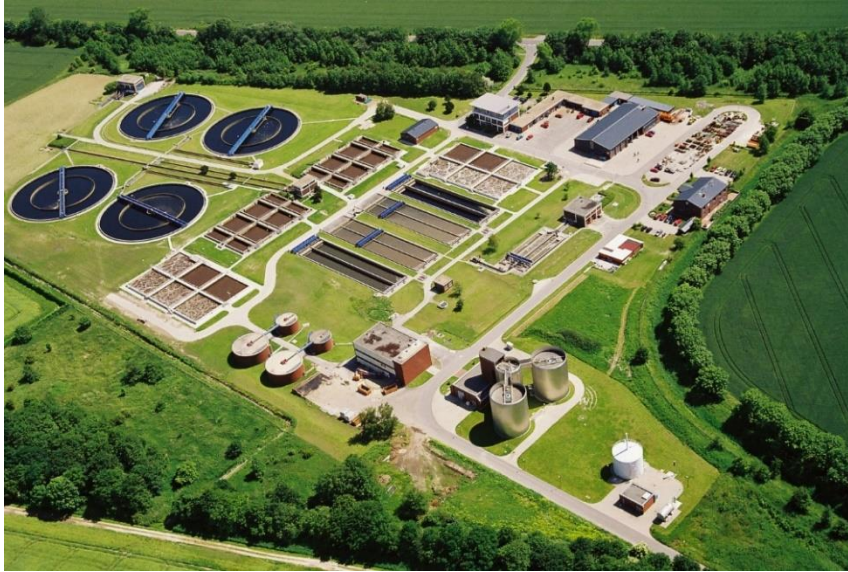
Abbildung 8 Draufsicht der Kläranlage Wilhelmshaven (Quelle: https://www.tbw-whv.de/technische )
