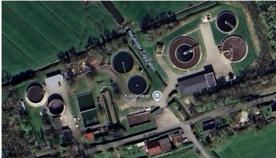
Abbildung 9 Draufsicht der Kläranlage Sande (Quelle: Google Maps, letzter Zugriff: 13.09.2024)
