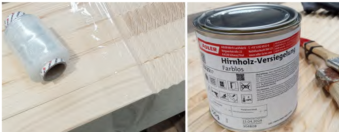
Bild 6.4: Links: Die Grundfläche der Vollholzlamellen wurde in Höhe der Mörtelfuge mit einem etwa 10cm breitem Streifen dünner Folie quer zur Faserrichtung ausgelegt, um direkten Kontakt des Quellmörtels mit dem Holz zu verhindern. Rechts: Die nach innen zeigende Stirnfläche der Knagge wurde mit Hirnholzversiegelung bestrichen, um zu vermeiden daß die Knagge dem Mörtel das Wasser entzieht und damit die Abbindung verhindert.
