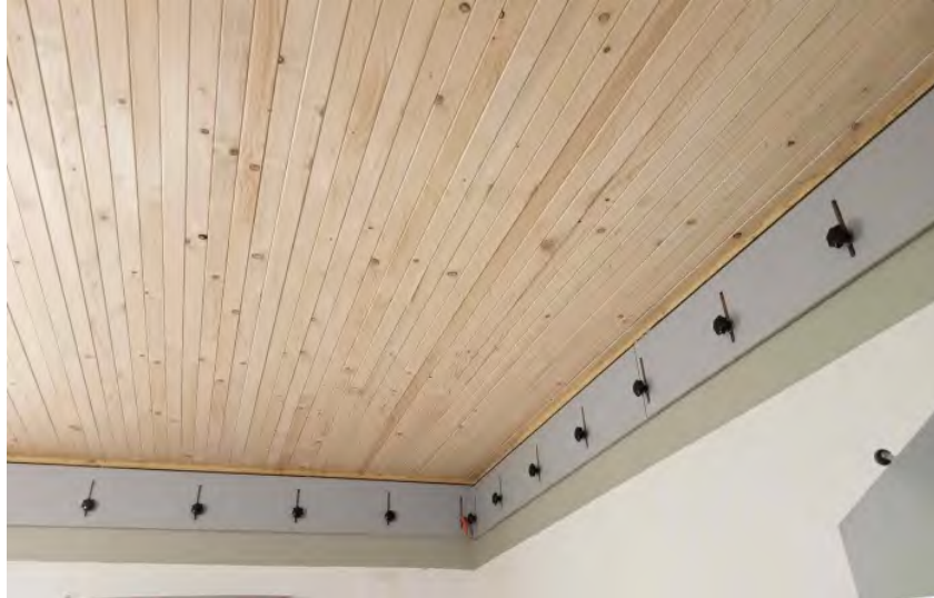
Bild 4.8: Die rückbaubare Holz-Beton-Verbunddecke von unten aus dem Empfangsraum gesehen. Die C24-Holzlamellen liegen ohne Abstand bündig aneinander.
