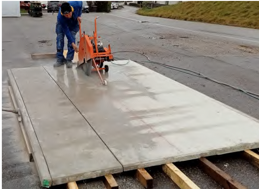
Bild 6.3: Eine der beiden 60mm dicken Filigrandecken, die für die Akustiktests verbaut worden war, wurde mit der Betonsäge in vier 600mm breite Streifen geschnitten worden.
