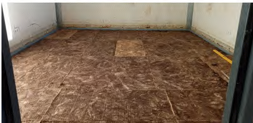
Bild 4.7: Einbringen der Schüttung und Trittschalldämmung auf die Betondecke im Senderraum. Oben: Rohe Holz-Beton-Verbunddecke von oben gesehen. Die Gitterträger sind klar erkennbar. Mitte: Schüttung mit Kalksplitt wurde 90 mm hoch eingebracht bis Oberkante Gitterträger. Unten: Trittschalldämmung aus Glaswolle mit 30 mm Dicke eingebracht. Auf diese Trittschalldämmung wurde die 50mm hohe Estrichdecke aus Fertigbeton mit Stahlbewehrung des ift-Rosenheim aufgelegt.
