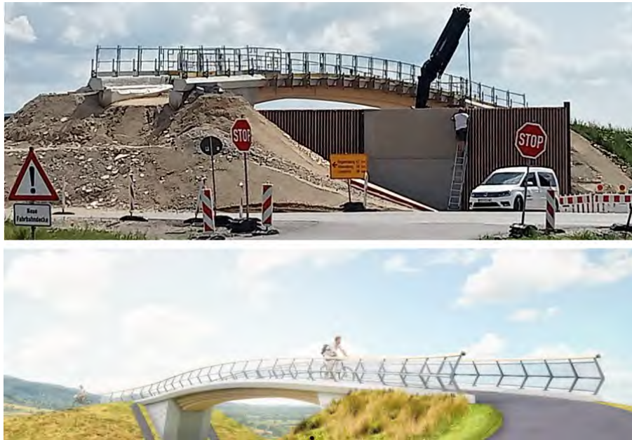
Bild 1.2: Oben: Gegenwärtiger Bau einer Holz-Beton-Verbundbrücke für Fußgänger und Radfahrer in 85077 Manching im Mai 2025. Unten: CAD-Zeichnung derselben Brücke (Miebach Ingenieure https://ib-miebach.de/projekte/holz-beton-hybrid-verbundbruecke-manching-ingolstadt/ , zuletzt aufgerufen Dezember 2024).
