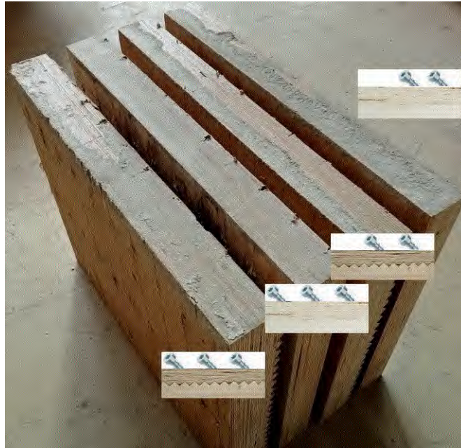
Bild 6.18: Vier Knaggen (einer Seite) der vier getesteten 600x5000x220mm Holz-Beton-Verbunddecke nebeneinanderstellt, um die unzureichende Befüllung der Quellschicht zu zeigen. Nur die unverzahnte Knagge mit sechs Schrauben pro Lamelle (zweite Knagge von links) war ausreichend mit Quellschicht befüllt und prompt wies diese die höchste Steifigkeit auf.
