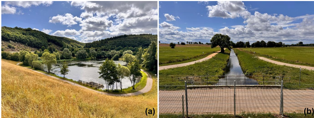
Abbildung 2: (a) HWRB Eicherscheid mit Dauerstau, (b) HWRB Weilerswist als Trockenbecken (Eigene Aufnahme, 2025)
