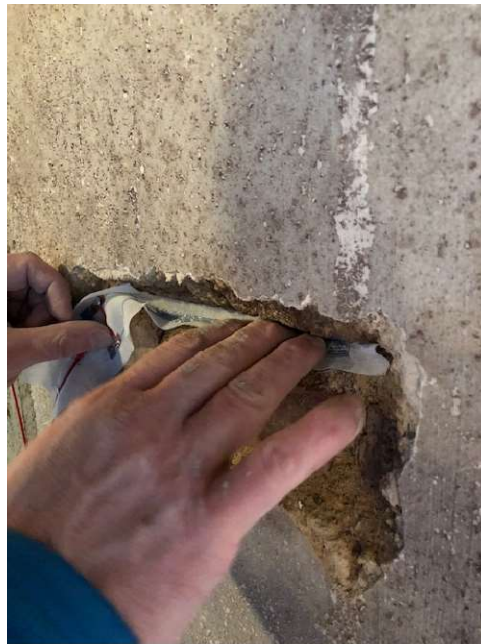
Abb. 6: Sensor wird in Fuge platziert
