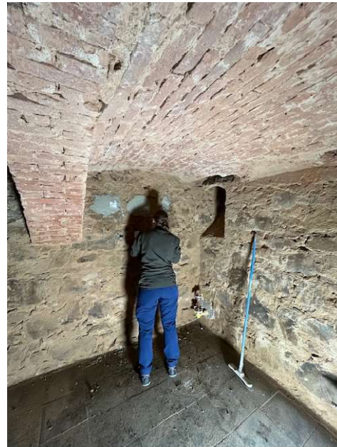
Abb. 22: Einbau der Sensoren
