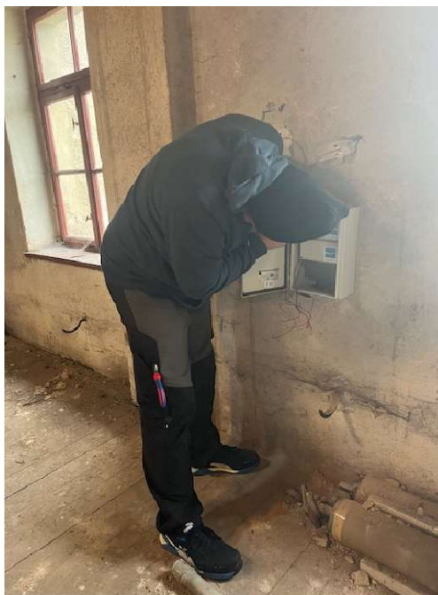
Abbildung 17: Rückbau in Hinterer Walkmühle
