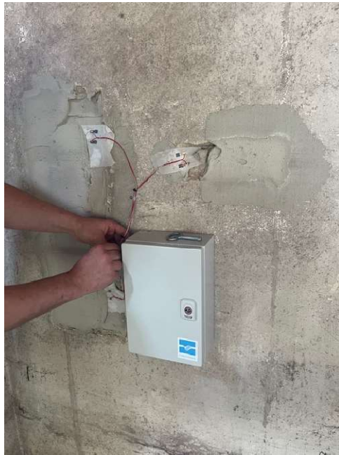
Abb. 11 und 12: Installation der Messbox durch FiberCheck
