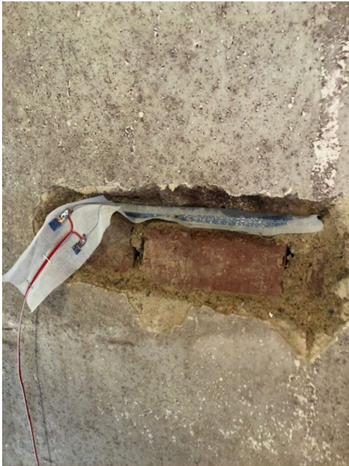
Abb. 7: Sensor im eingelegten Zustand
