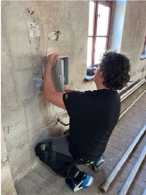
Abb. 11 und 12: Installation der Messbox durch FiberCheck
