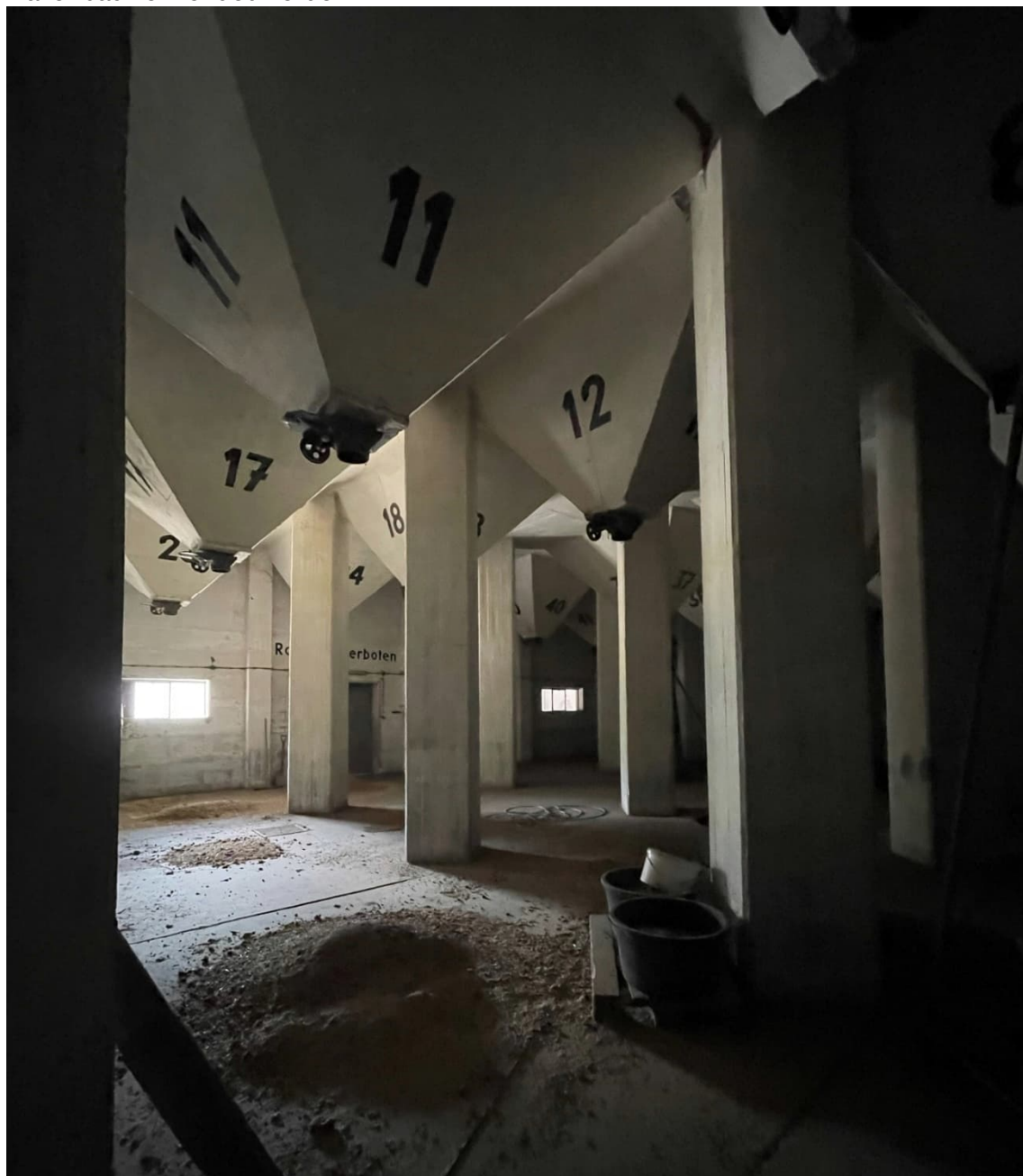
Abbildung 22 - Bestandsaufnahme der Siloanlagen vom 13.03.2023
