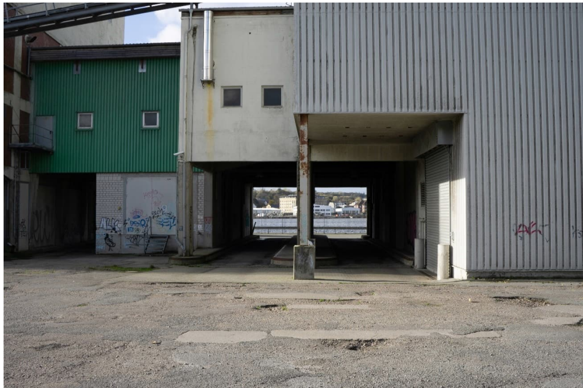
Abbildung 24 - Blick von Osten auf den 1980 errichteten Speicher, Durchfahrt zur Förde
