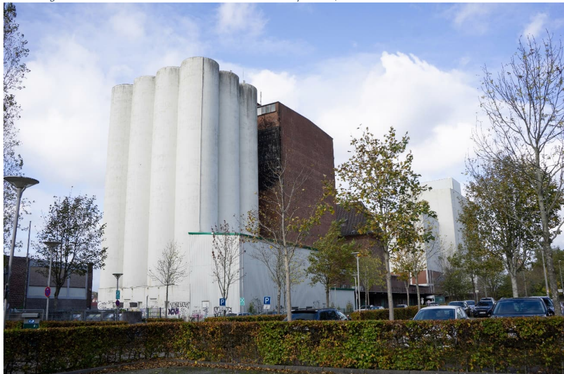
Abbildung 25 - Blick auf die 1969 errichteten Stahlbetonzylinder im Süden des Grundstücks
