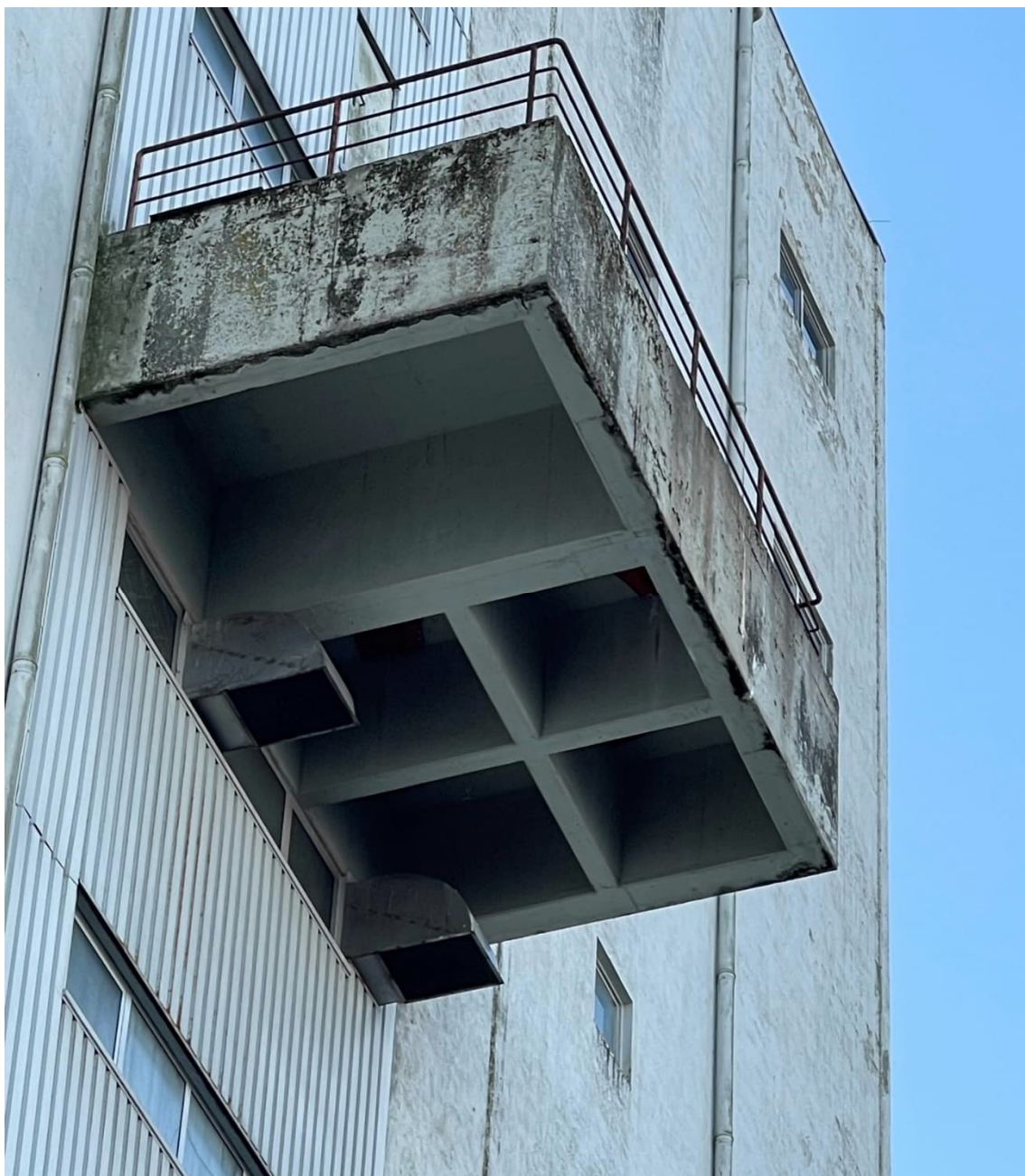
Abbildung 27 - Blick auf Fassade des HaGe-Speichers, Bj 1980
