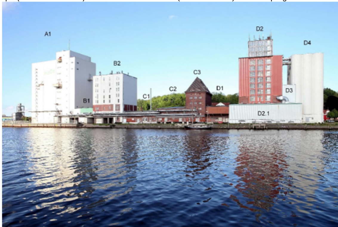
Abbildung 31 - Abbildung - Ansicht Silogebäude mit Nummerierung
