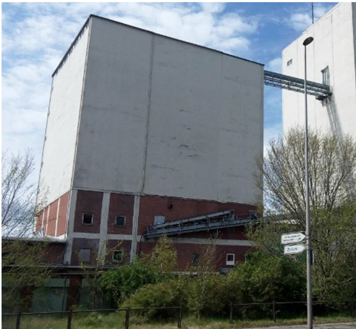
Abbildung 39 - 8-geschossiges Industriegebäude (Pressenhaus I + II + III), Baujahr ca. 1970
