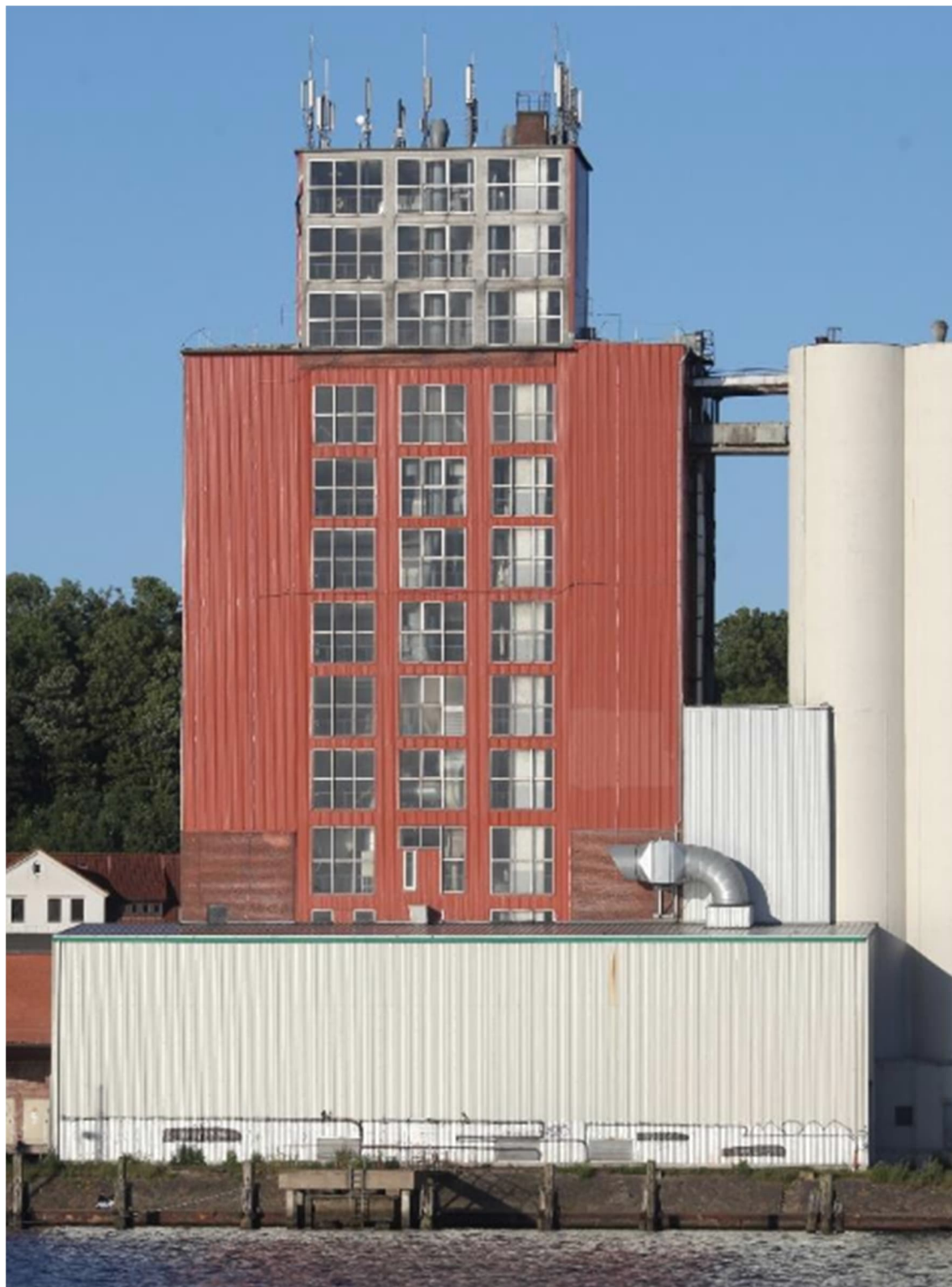
Abbildung 43 - Ansicht Silo-Gebäude D2
