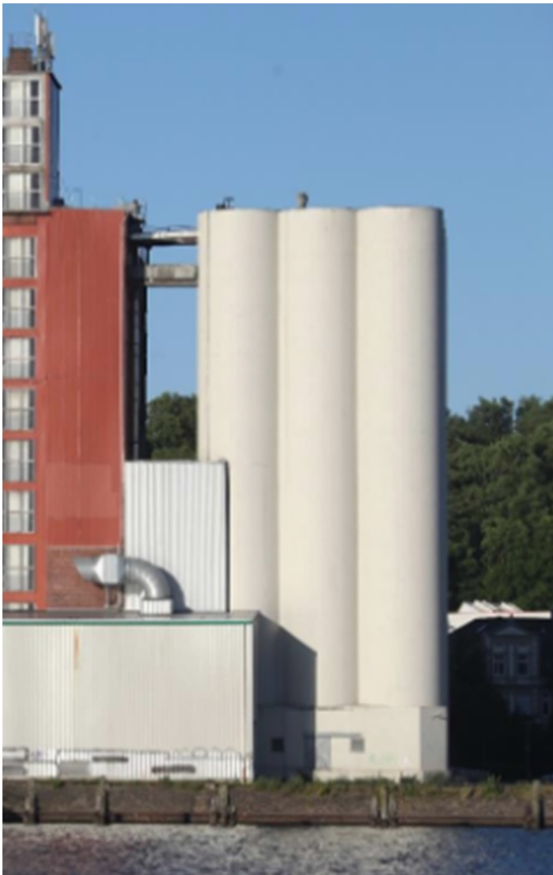
Abbildung 44 - Foto Rundsilo Gebäude D4
