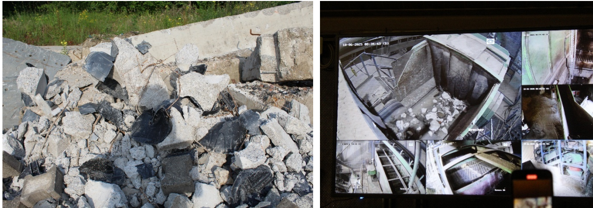
Abbildung 32: Mittels Abbruchschere vorgebrochene Versuchskörper (links) und Brechanlage mit eingefülltem Abbruchmaterial (rechts)
