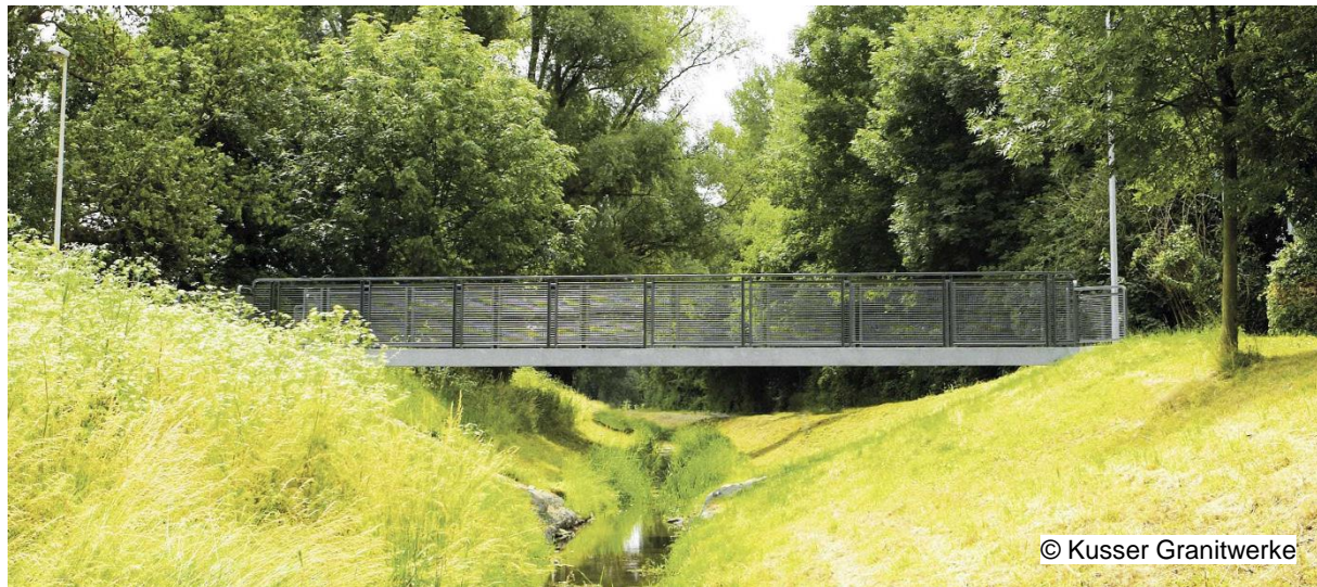
Abbildung 2: Vorgespannte Granitsegmentbrücke der Kusser Granitwerke GmbH am Kupferstrang in Hildesheim
