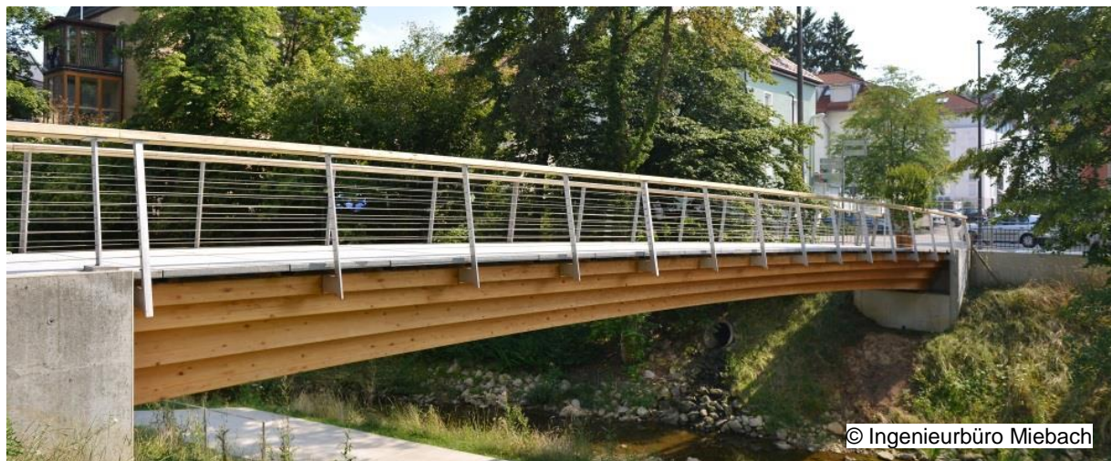
Abbildung 1: Holz-Granit-Brücke „Schillersteg“ in Schwäbisch Gmünd: Blockverleimter Brett-schicht-holzträger mit nichttragenden Granitplatten als Brückenbelag
