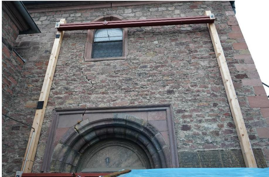
*Abb. 2: Rissverlauf im Innenbereich der Synagoge, Sicherungsmaßnahme durch lastabtragende Gerüststellung.*
