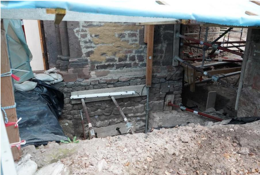
*Abb. 3: Freilegung des Fundamentes unter archäologischer Begleitung mit Nachweis einer Lehmschicht und tonreichen Sedimentschichten.*
