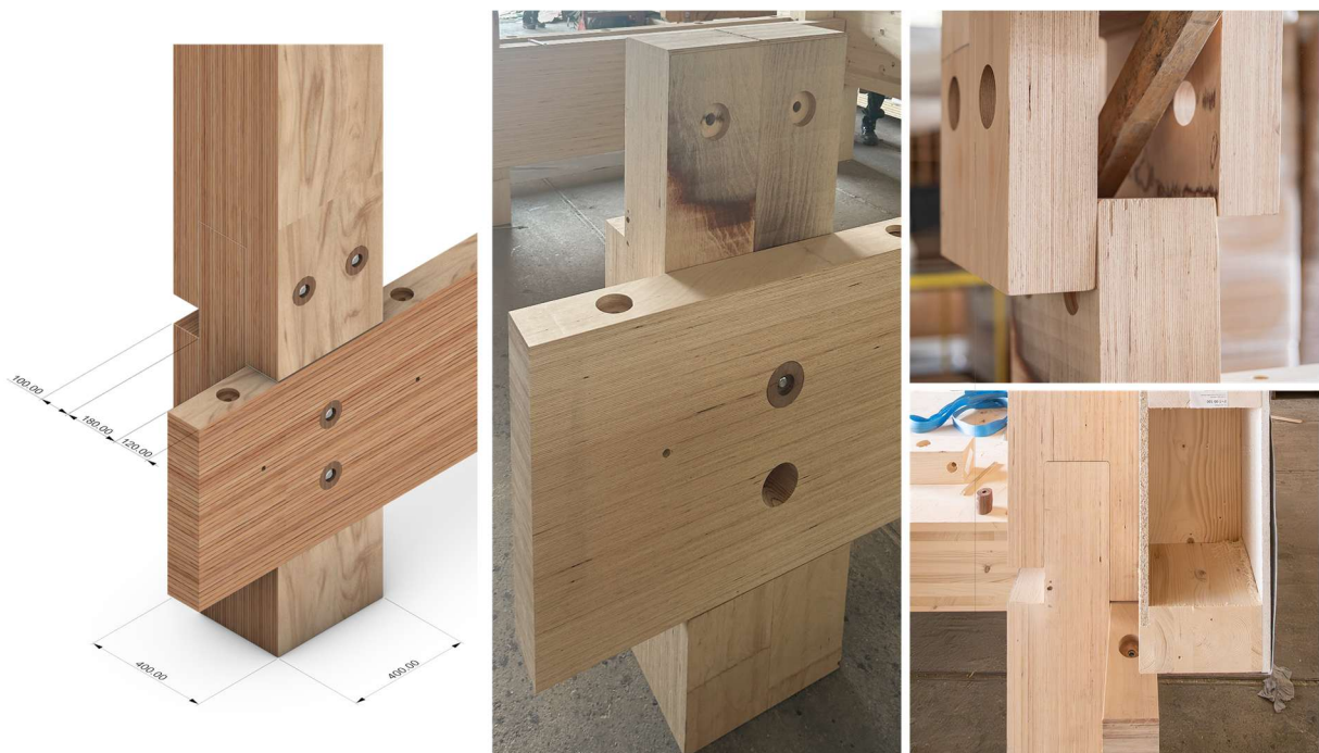
Abbildung 21: Tragwerk mit der Nut-Feder-Konstruktion
