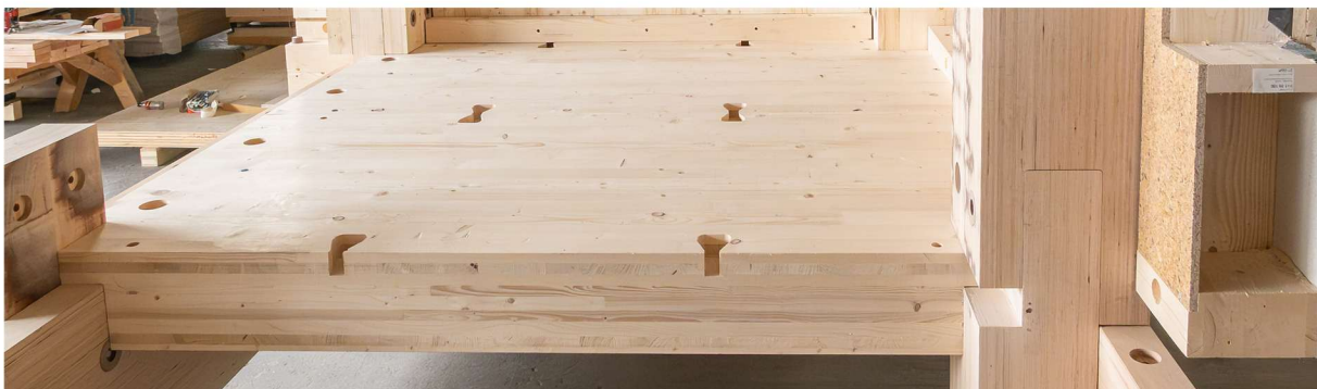
Abbildung 23: Deckenelemente aus CLT Box
