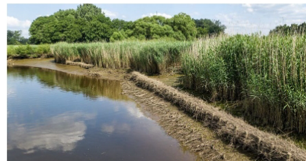
Abbildung 10: Buschkiste und vorliegende Totholz-Spreitlage (Quelle Bundesanstalt für Wasserbau, CCBY 4.0, 2020)
