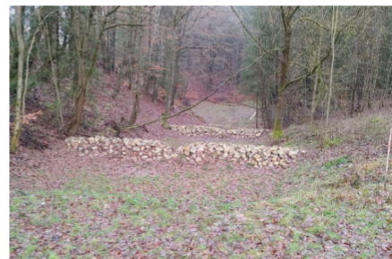
Abbildung 7: Abfluss- und Sedimentmindernde Struktur in einem steilen Waldabschnitt (Quelle: Weiß, 2024)
