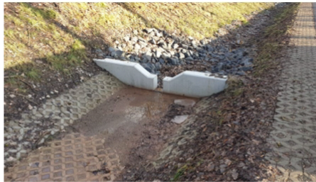
Abbildung 8: Exemplarischer Rückhalt in Gräben (Quelle: Weiß, 2024)
