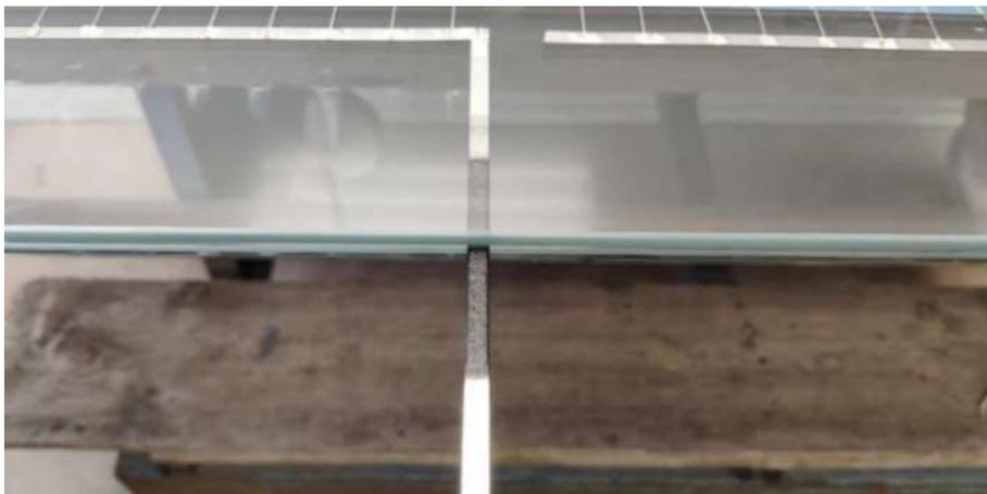
*Abbildung 7: Elektrischer Verbinder isoliert mit Plasti Dip Liquid Tape*
