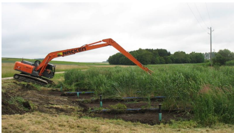
Abbildung 3-26: Langarmbagger mit 17 m Reichweite beim Räumen eines Bodenfilters (Foto: Ingo Bruch)
