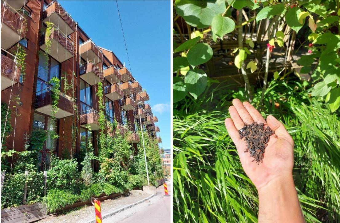
Abbildung 4: Im Boden gepflanzte Fassadenbegrünung in Malmö (Foto links) sowie das verwendete Pflanzenkohle-Substrat (Foto rechts).
