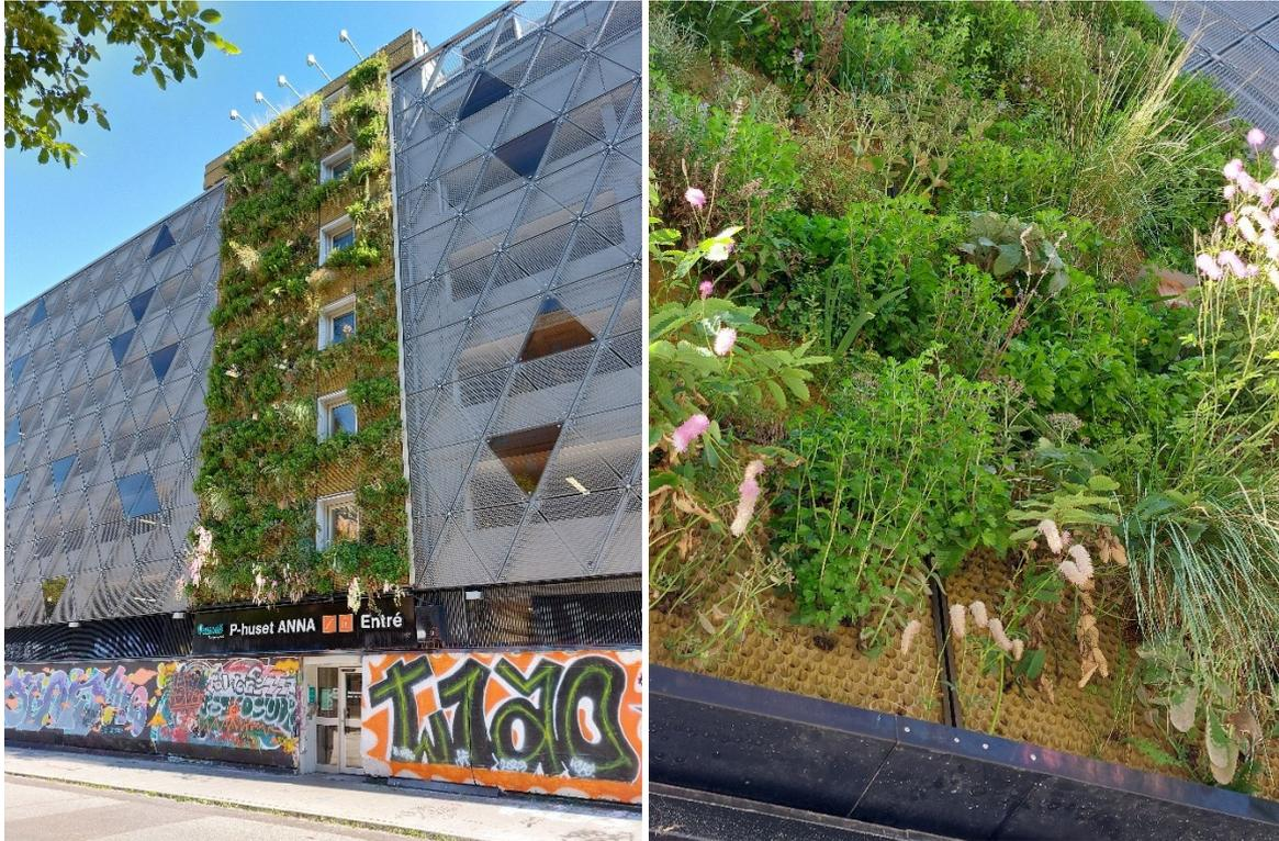
Abbildung 2: Eine Seite des Parkhauses in Malmö in der Totalen (Foto links), rechts ein genauerer Blick auf die verwendeten Wandmodule nebst Bepflanzung.
