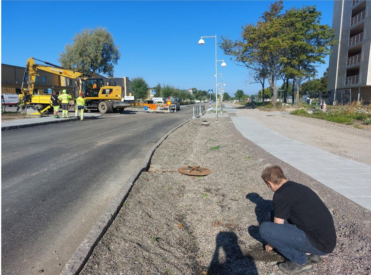
*Abbildung 6: Die umliegenden Flächen entwässern in das Regenbeet - so kommt es hier regelmäßig zu kurzzeitigem Wasserstau und die gepflanzten Stauden werden ausreichend versorgt.*
