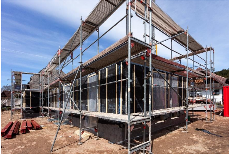
Abbildung 5. Baustelle der Inara Suites.
