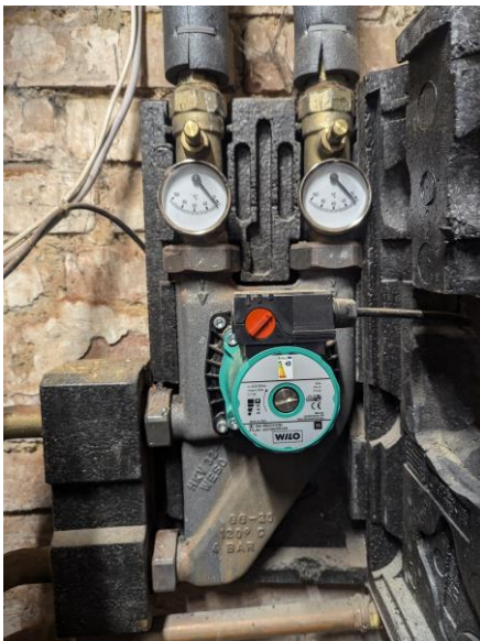
Abbildung 8: Pumpengruppe Heizung
