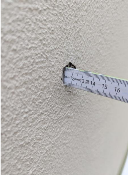
Abbildung 9: Fehlstelle Wärmedämmverbundsystem
