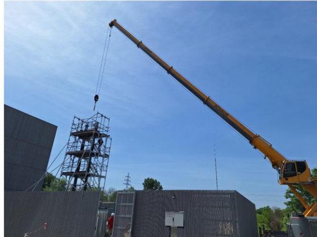
Abbildung 39: Anheben der Kolonne zur Montage der neuen modifizierten Reaktorauflageplatten mit vergrößertem Auslassdurchmesser zum Einbau der größeren Pumpe.
