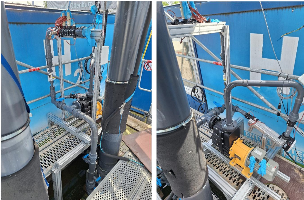
Abbildung 40: Montage der vergrößerten, selbstansaugenden Pumpe.
