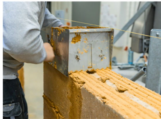
Abbildung 98: Auftrag des Lehmdünnbettmörtels mit einem Mörtelschlitten
