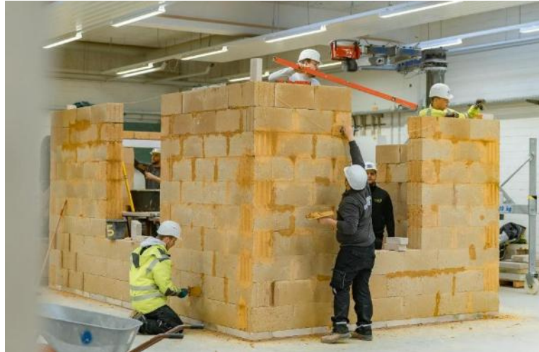
Abbildung 34: Lehrbaustelle ASK Kassel - Wände errichtet mit Plan-Lehmsteinen in 16DF-Format und Lehmdünnbettmörtel
