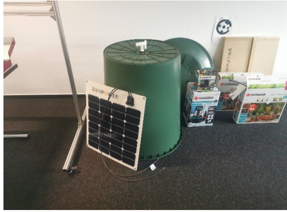
Abbildung 6: Sammelbehälter und Photovoltaikanlage
