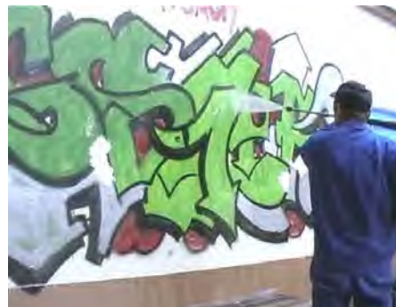
2. Fläche mit Heißwasser-Hochdruckreiniger erwärmen (ca. 90 °)
