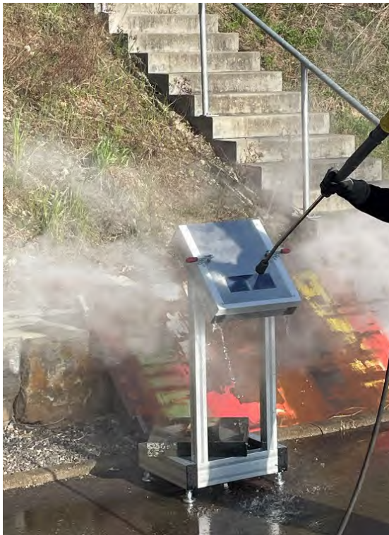
Abb. 20: Eigens von der Firma Kärcher SE angefertigte Halterung inkl. Schablone für die Vortests mit Hochdruck- und Trockeneisstrahlen (R1, R2).
