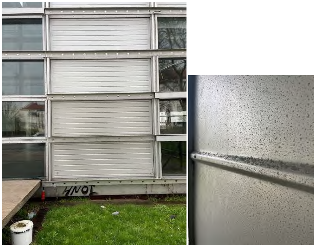
Abb. 44 und 45: Zustand 2023: Gesamtansicht und Detail.
