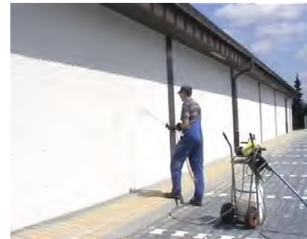
1. AGS 3502 / 3512 im Kreuzgang in 2 Schichten aufsprühen
