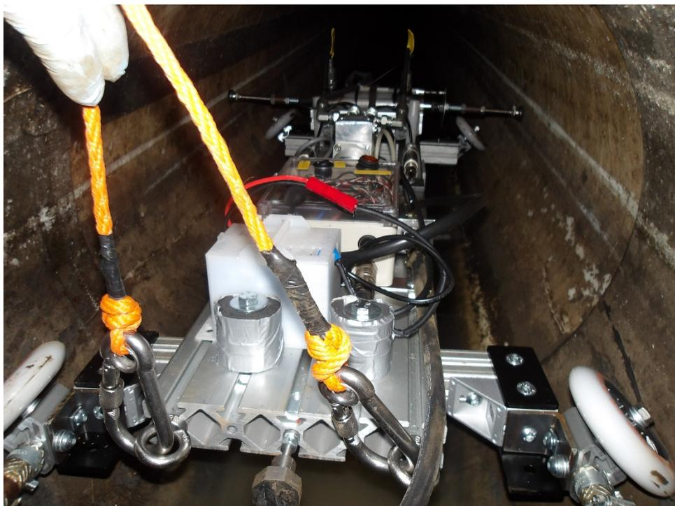
Bild 24 Mikro-MAC, Einbau in der Haltung vom Schacht aus
