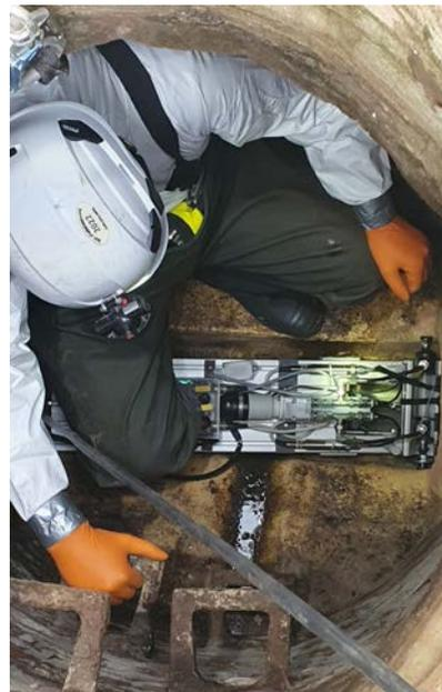
**Bild 20** Einsatz des Micro-MAC im Kanal DN 300:
