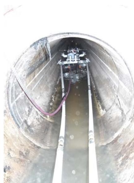
**Bild 19** Einsatz des Micro-MAC im Kanal DN 600:
