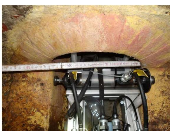
**Bild 21** Einsatz des Micro-MAC im Kanal DN 300:
