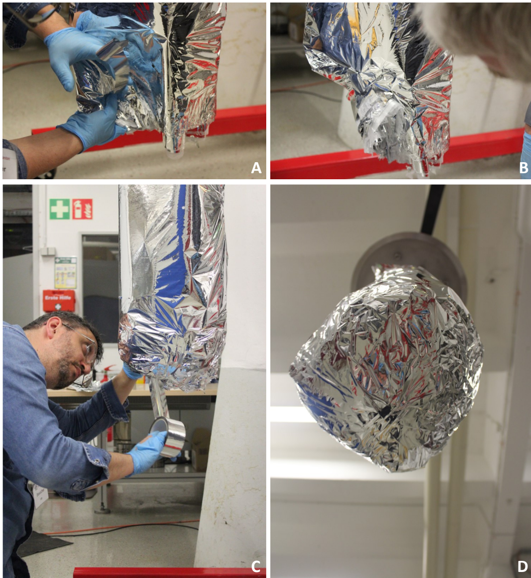
Abbildung 14: Verschießen des unteren MLI-Überstands an Wärmeübertrager und LH2-Speichertank. Um die Unterseite zu verschließen (nach dem Anbringen aller MLI-Blankets) werden wiederholt Abschnitte des unteren Überstands umgeklappt und mit Klebeband fixiert (A und B). Ein Kontakt zwischen äußerer und innerer Schicht wird vermieden.
