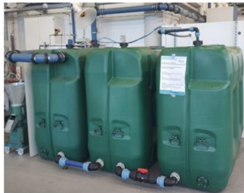
Abbildung 1: Regenwassertanks genutzt zur Sammlung von Regenwasser. (A) private Tonnen (beispielhaft), (B) 1000 L-Wassertank an der Hochschule Rhein-Waal.
