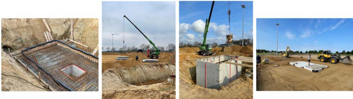
Abbildung 2: Fotos vom Bau des Probenahmekellers
