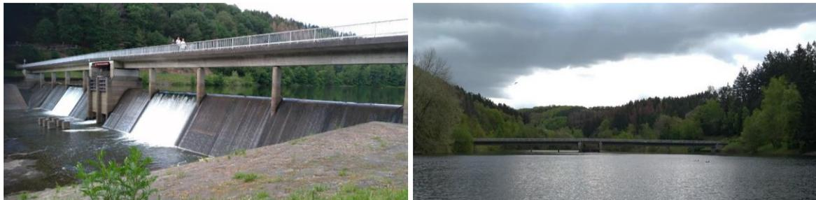
Abbildung 18: links: Absperrbauwerk der Wupper-Vorsperre mit Wehrüberfall und geöffnetem Grundablass; rechts: überstautes Absperrbauwerk der Wupper-Vorsperre mit ausgeglichenem Wasserstand im Ober- und Unterwasser.
