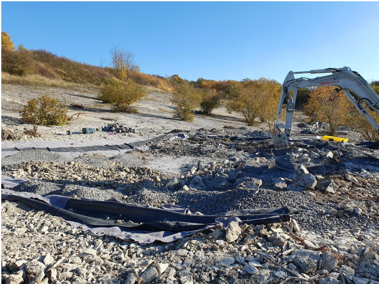
Abbildung 8: Anlage eines ablassbaren Foliengewässers. (Foto: ÖNSA/Valentin Dienst)
