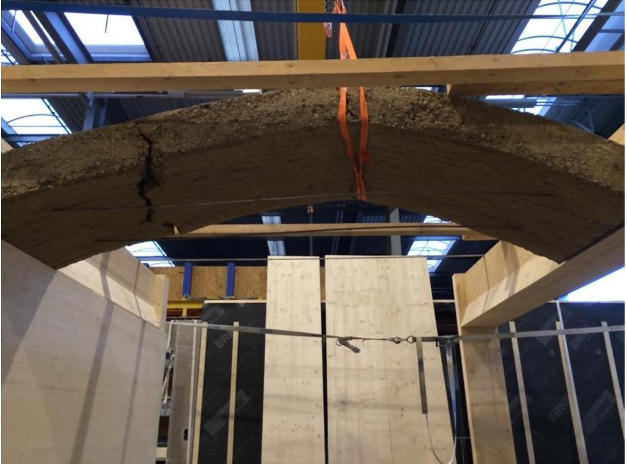
16 Rückbau durch Anheben der Bögen
