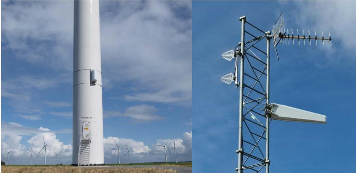
Abb. 2: Beispiel einer Dislozierung eines PARASOL-Sensors am Turm einer Windenergieanlage (links) und der Anbringung von höhenversetzbaren Antennen auf einem Antennenmast (rechts). (Quelle PARASOL GmbH & Co. KG)
