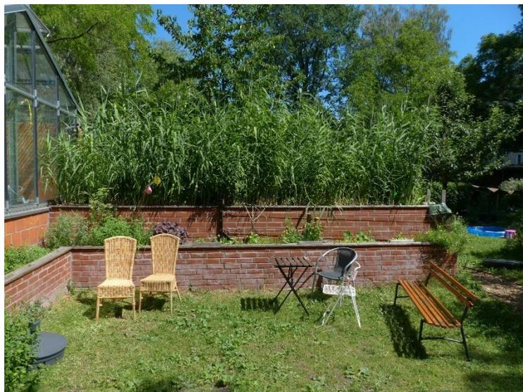
Abbildung 4: Bewachsener Bodenfilter im Projekt "Lichte Weiten", Berlin (eigene Aufnahme)
