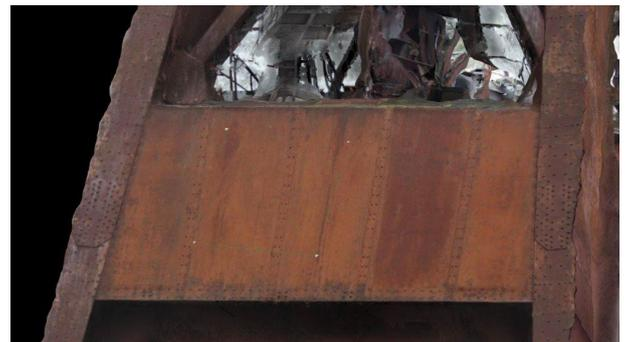
**Abbildung 11:** Am Schachtgerüst (im vorliegenden Fall Pluto, Herne) werden Flächen identifiziert und die 3D-Koordinaten bestimmt. Die Passpunkte bilden hier die Ecken eines Quadrats (rote Punkte, rechtes Bild).
