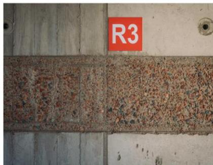
Bilder von der Musterbude von OTTO WULFF bei der verschiedene Recycling-Betons testweise verbaut wurden; © MiguelFerrazAraújo
