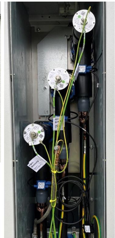
Abbildung 3: Abgang in Ortsnetzstation mit Strom- und Spannungswandlern
