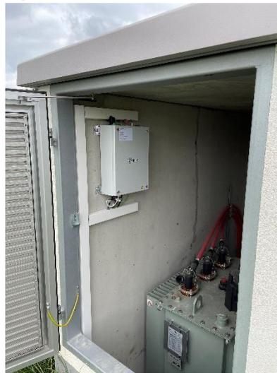
Abbildung 2: PMU-Messung in Ortsnetzstation
