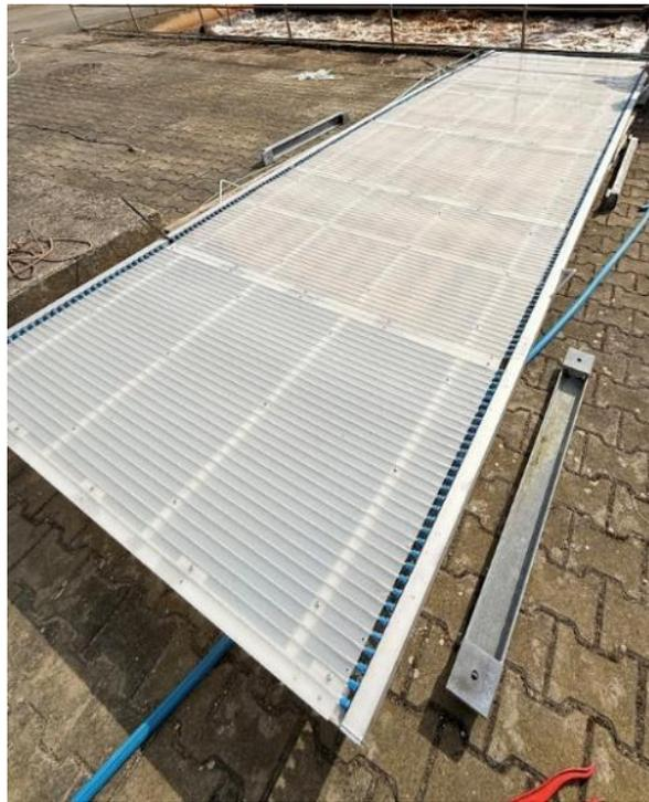
**Abbildung 30:** Bild des 6 m x 2 m Rahmens der Silikonröhrchen auf der Industriekläranlage vor dem Einbau.
