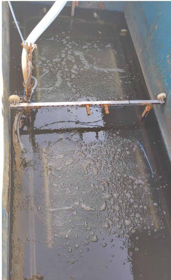
Abbildung 38: Eingebaute Belüfter in den Tanks; Tellerbelüfter Tank 2 (links), MILA Tank 1 (rechts).
