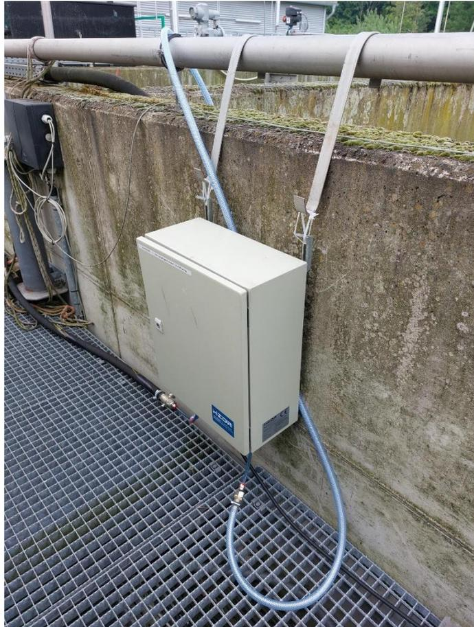
**Abbildung 23: Installierte Druckspüleinrichtung des HZDR an der Versuchskläranlage der EGLV auf der Kläranlage „Emschermündung“.**
