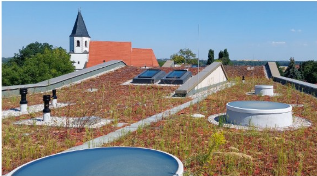
Retentionsgründach der Grundschule Dölzig (Foto: Andrea Bernhardt)
