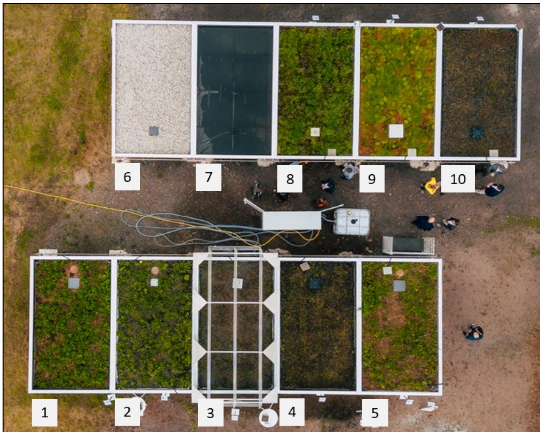
Abbildung 3: Drohnenaufnahme der Versuchsanlage zur Eröffnungsveranstaltung am 31.05.2025 (Foto: Leipziger Wasserwerke, Ergänzungen: Andrea Bernhardt) mit Dachbezeichnung
