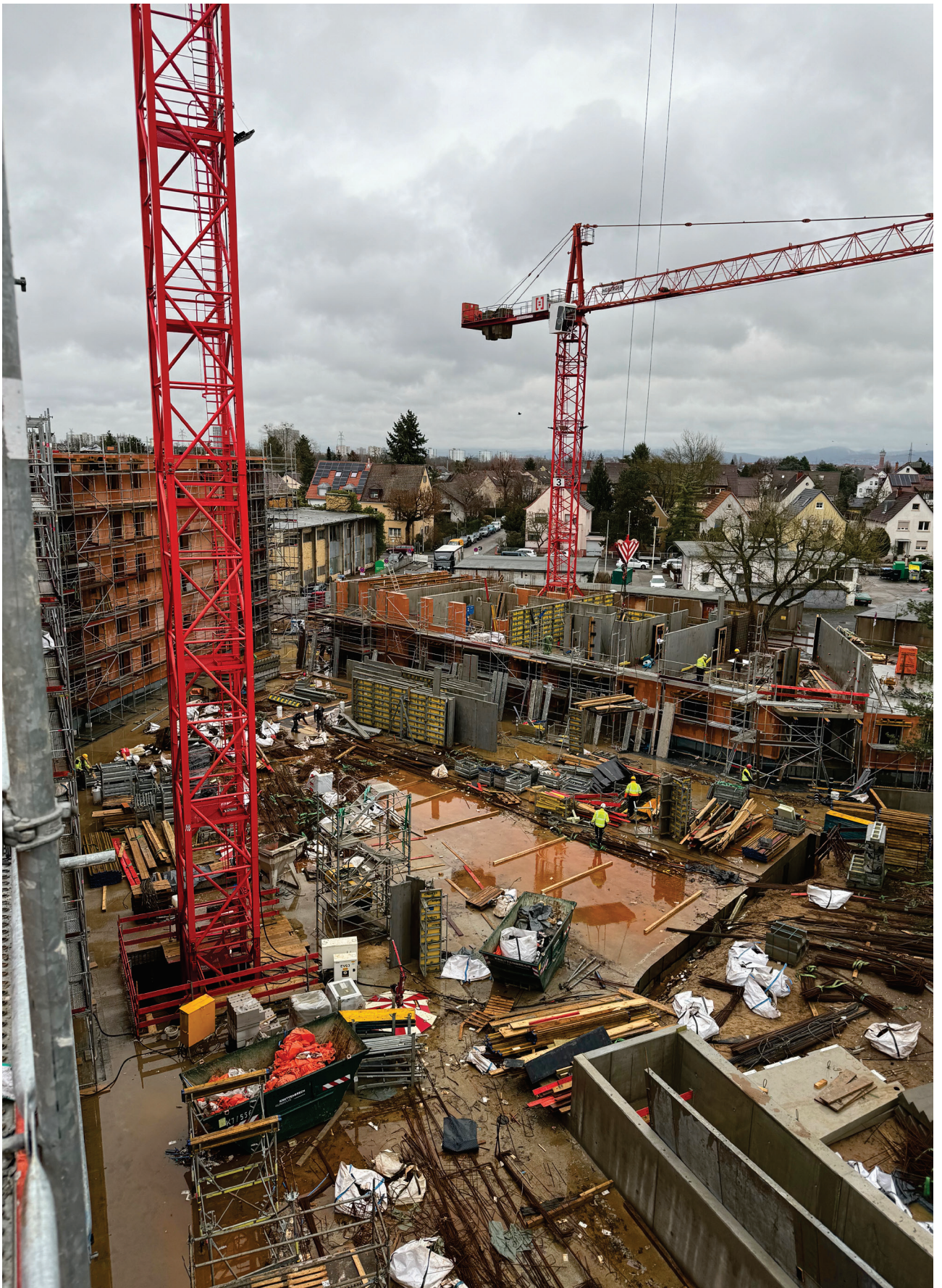
Foto vom Rohbau aus dem Jahr 2024. In der Mitte ist deutlich der Unterbau der Teichanlage zu erkennen Quelle: FG est
