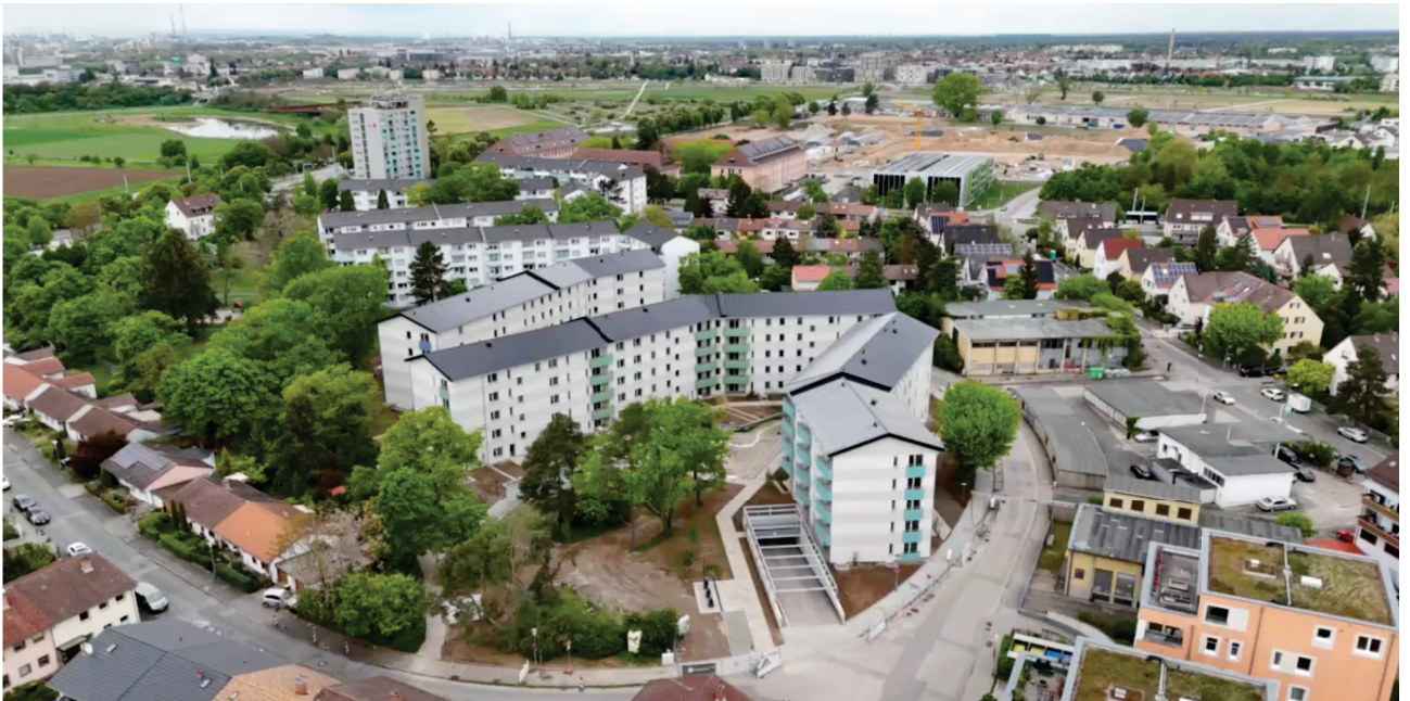
Die Gesamtanlage kurz vor Fertigstellung, aus der Vogelperspektive (oben), bei den letzten Arbeiten an der Bepflanzung (unten,li), sowie während Abdichtungsarbeiten an den Teichen (unten,re) Quelle: FG est
