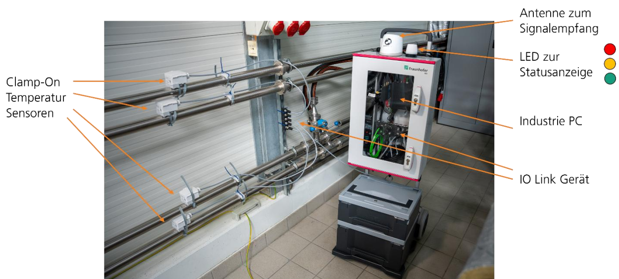
Abbildung 18: Darstellung des Messsystems für die Produktion in Molkereiindustrie
