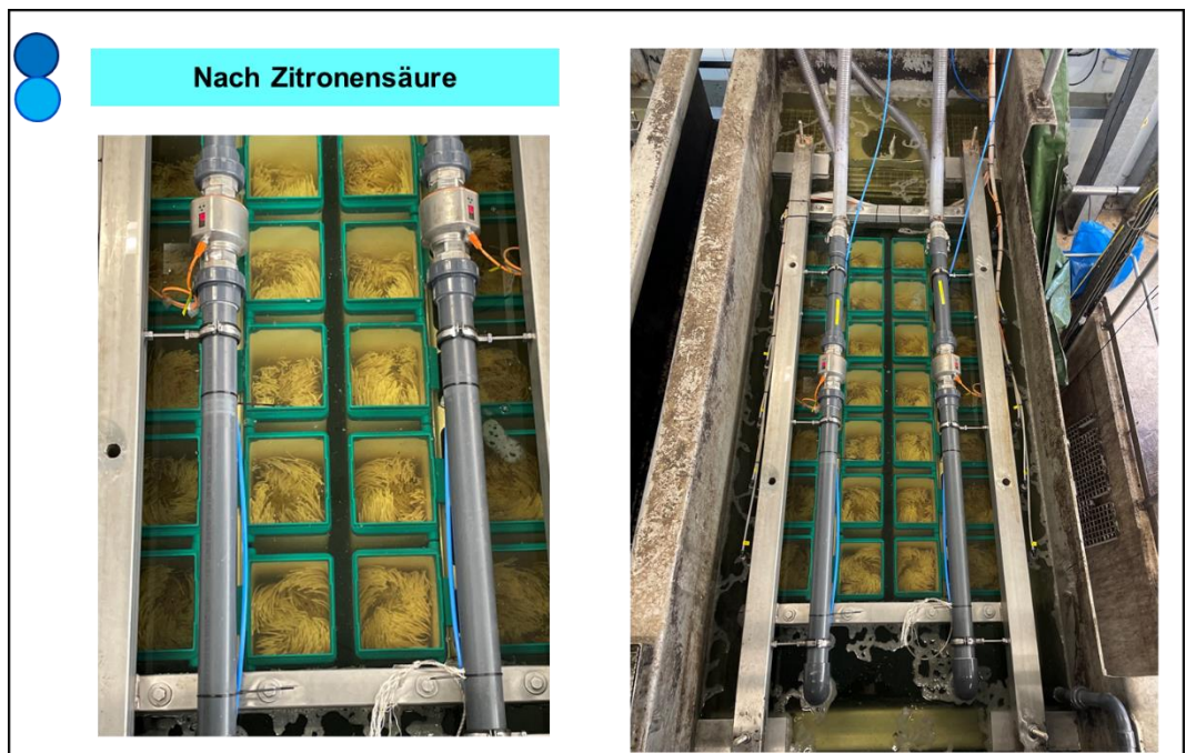
Bild-28: MSG-500 nach Intensiv- reinigung Mit NaOCl und Zitronensäure
