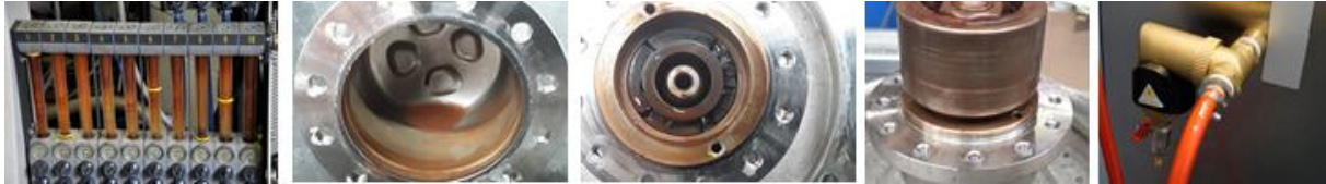
Abbildung 21 - Schadensfall an einer Pumpe
