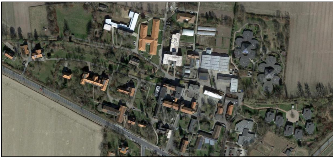
Abbildung 9 - Dorf Neuerkerode, Schwerpunkt der Bau- und Betriebsaufgaben der ESN
