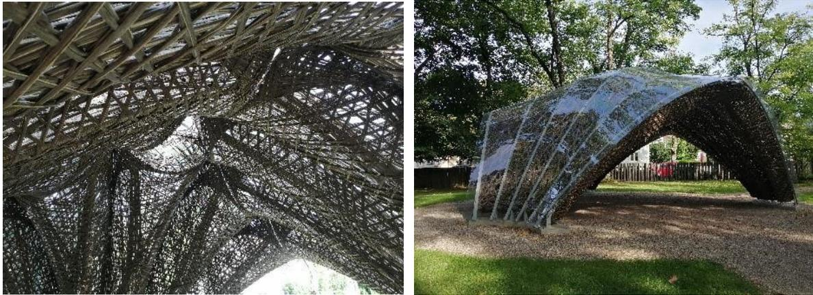
Abbildung 30: livMatS Pavillon bei Besichtigung im September 2021, keine Delaminierung der Schalenhaut, intakte Faserstruktur
