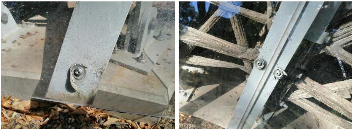
Abbildung 33: Beschädigung der gummierten Unterlegscheiben, August 2022
