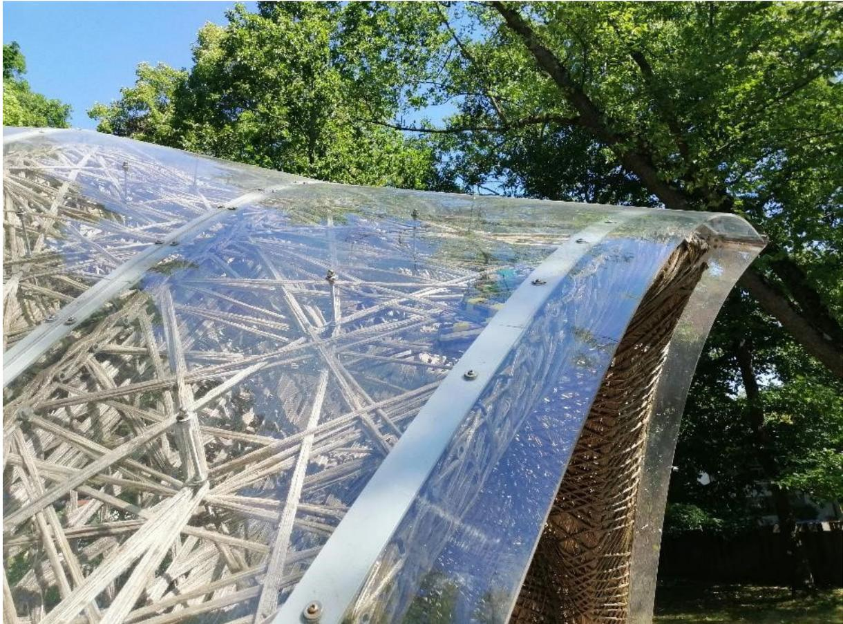
Abbildung 32: livMatS Pavillon bei Besichtigung im August 2022, keine Delaminierung der Schalenhaut, intakte Faserstruktur, unbeschädigte Probekörper
