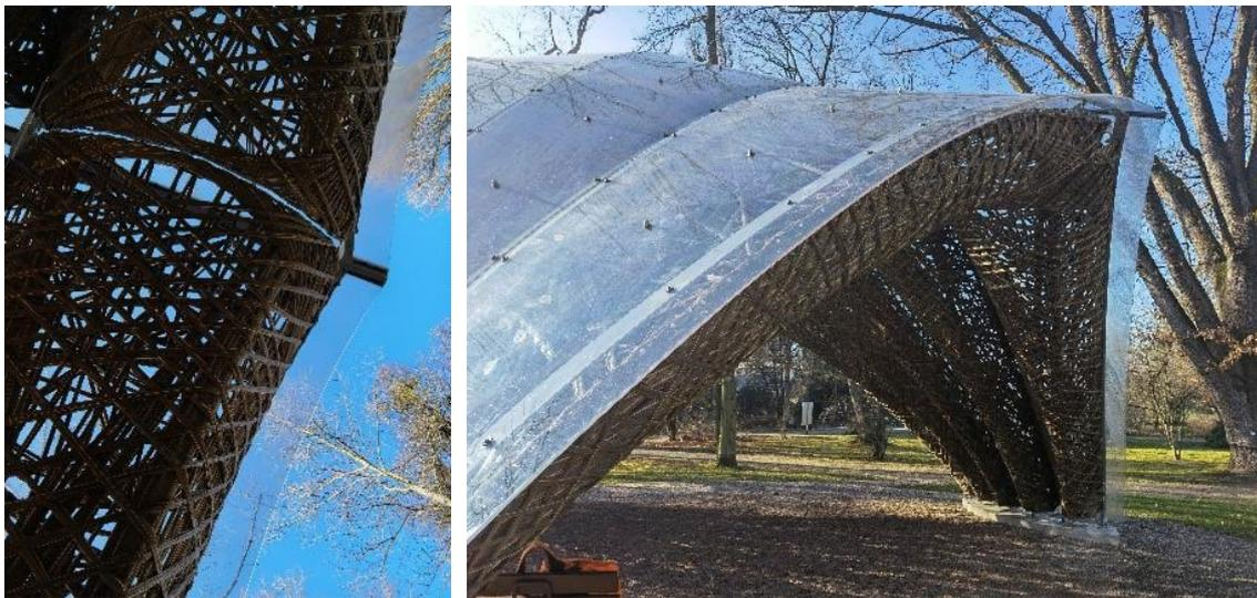
Abbildung 31: livMatS Pavillon bei Besichtigung im Februar 2022, keine Delaminierung der Schalenhaut, intakte Faserstruktur
