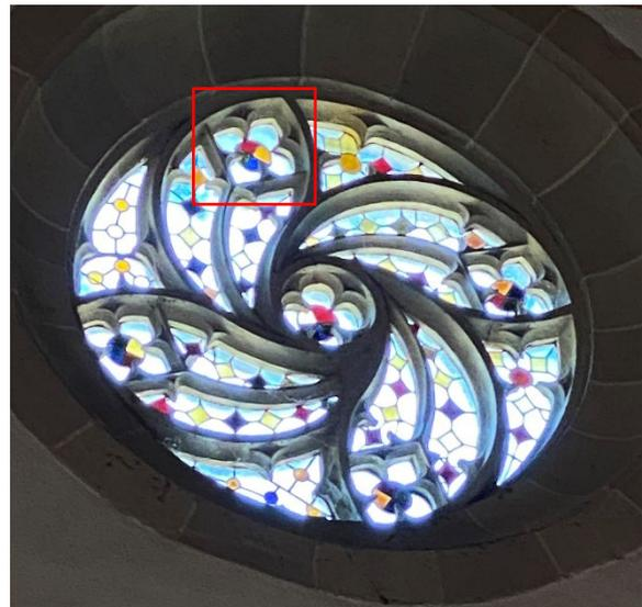
Abbildung 2: Links: Westfassade der Herrgottskirche während der Untersuchung der teilweise beschichteten Verglasung in situ im Jahr 2021. Oben: Ansicht des Rundfensters von der Innenseite; der beschichtete Vierpass befindet sich oben links; die Bewertung der Beschichtung erfolgte auf der Außenseite.
