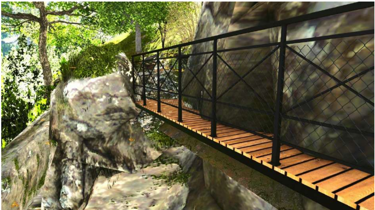
Abb. 105: Beispiel für ein Geländer an der Teufelsbrücke, in Anlehnung auf die Ausformung des frühen 20. Jahrhunderts, Variante mit Metallgeländer, Ewa Adamczak, 2023.
