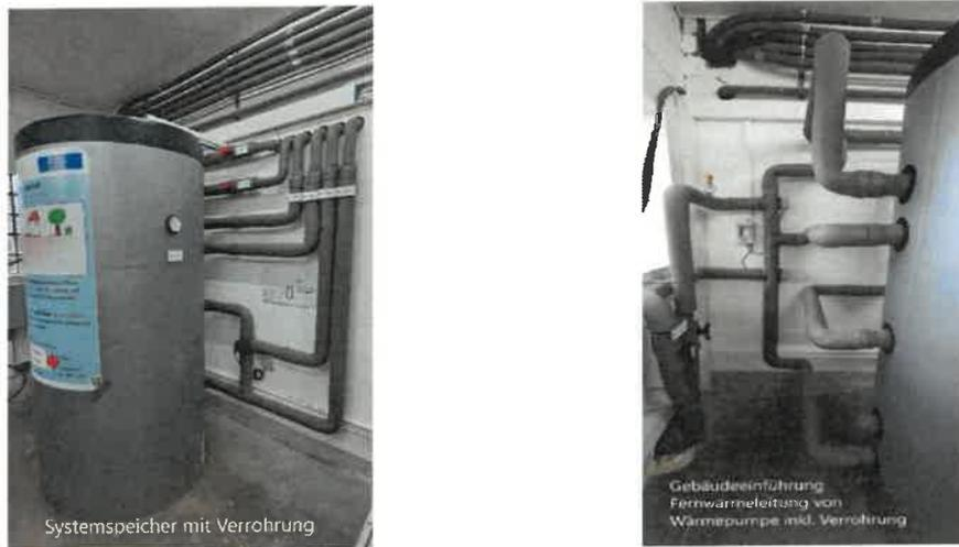
Abbildung 2-3: Pufferpeicher (links) und Anschluss an Gebäudeheizung (rechts)
