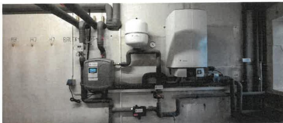
Abbildung 2-4: Frishwasserstation mit Nachheizung
