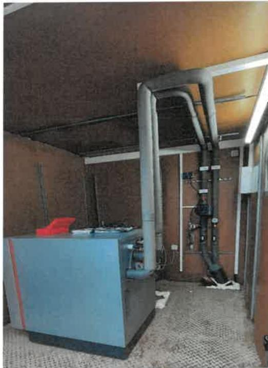
Abbildung 2-5: Wärmepumpe GT2 mit abgehenden Leitungen zur Gebäudeheizung inklusive Zirkulationspumpe
