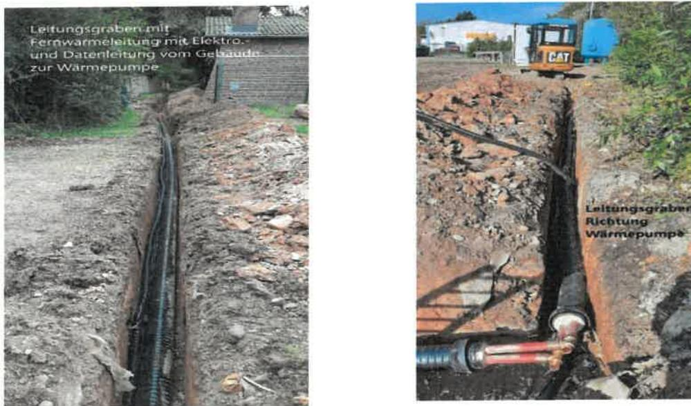
Abbildung 2-2: Leitungsgraben zum Gebäude (links) und zwischen den Wärmepumpen (rechts)
