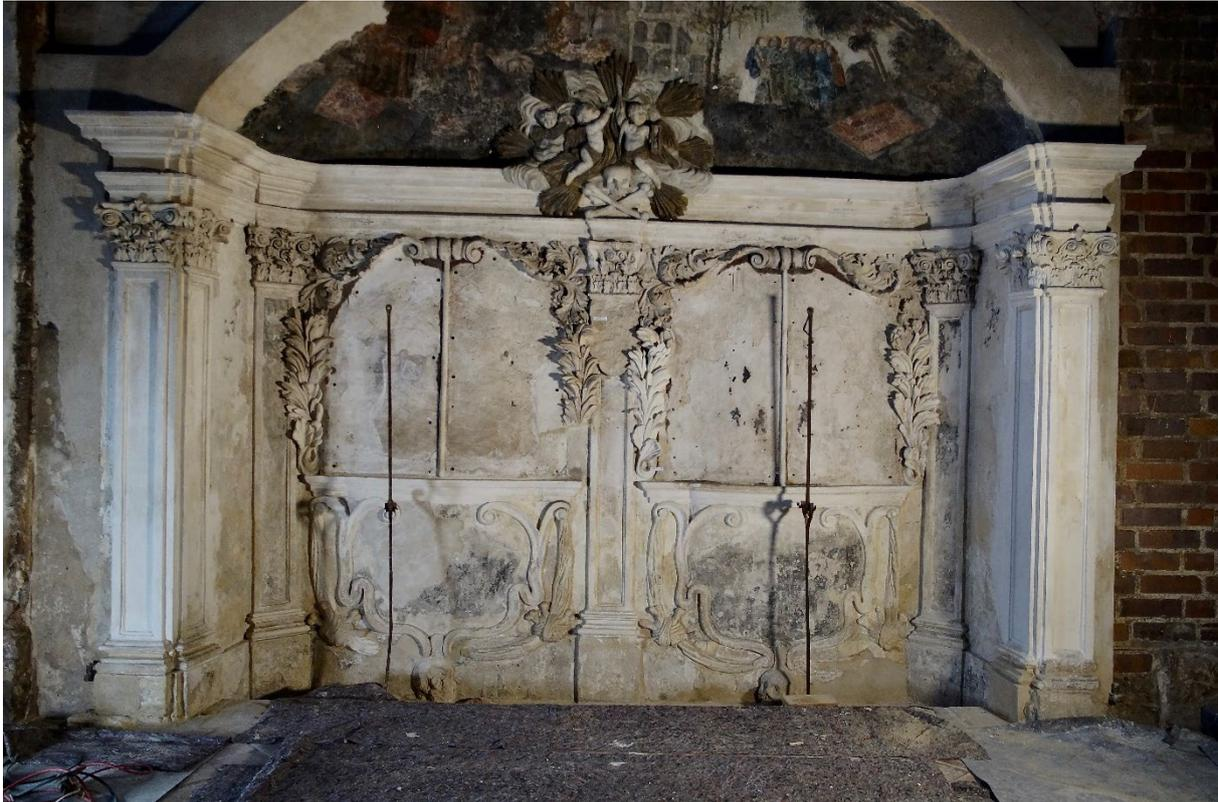
Abb.16: Epitaphnische nach Abschluss der Konservierung und Ergänzung der Kalkstuckarchitektur vor dem Einbau der Metallplatten, Foto: Anke Höchel-Pradel 2024
