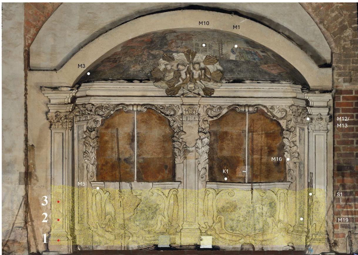
Abb. 5: Barockes Erbbegräbnis mit Darstellung der aktiven Salzsadenszone (gelb schraffiert) und den Probenahmestellen, links sind die Bohrmehlentnahmestellen für die quantitative Salzuntersuchung rot markiert, Bild: Nicole Köllner, ergänzt: Steffen Laue
