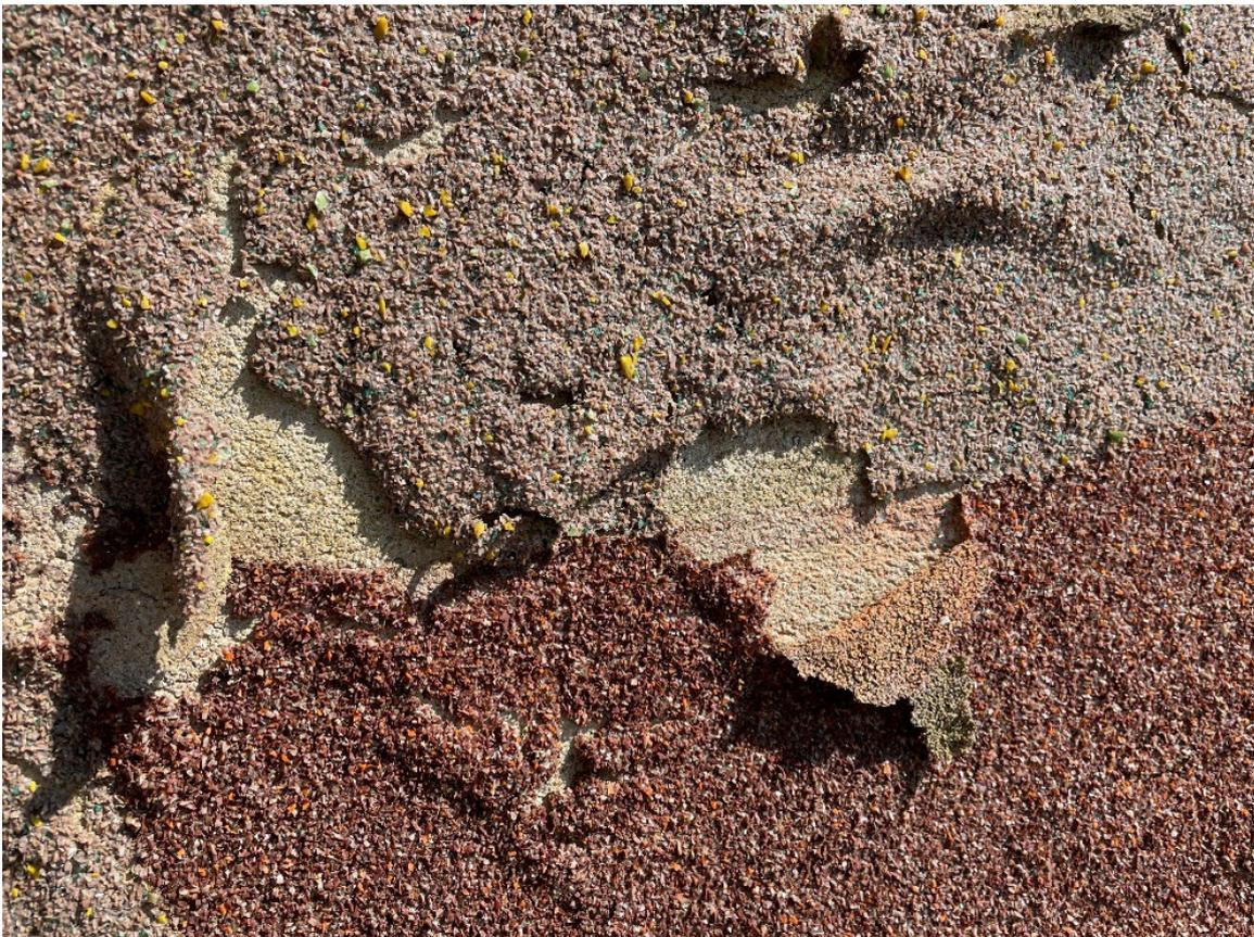
Abb. 21: Detail der Glaskröseln mit Schadensbild, hier Grenze von grau zu braun mit anhaftender Grundierung auf der Unterseite der braunen Glaskröseln
