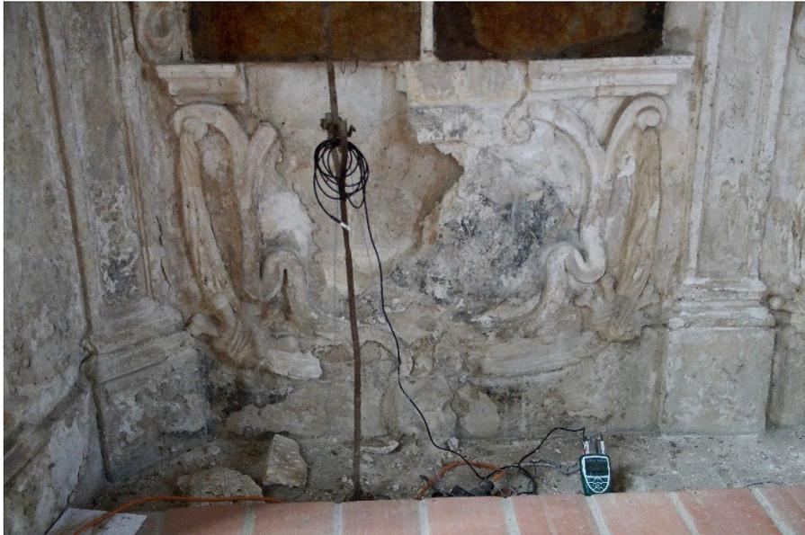
Abb. 15: Stuckmaterialien, Schadensbild im nördlichen Sockelbereich mit Klimamessgeräten
